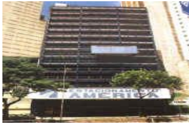
Figura 7: Edifício Garagem América - São Paulo 14
