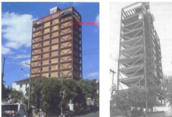
Figura 9:Edif. Saraiva Marinho – Belo Horizonte (1987) 16
