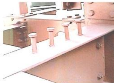
Figura 21: Resultado final da soldagem do conector tipo pino com cabeça (stud) 40
