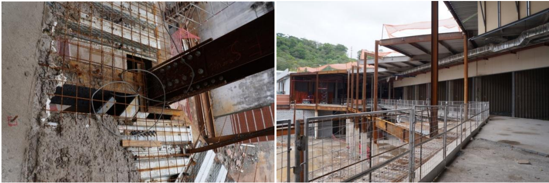
Figura 17: Etapas construtivas da laje mista do anexo Shopping do Vale, Ipatinga, Estado de Minas Gerais.( Fotos do Autor) 33
