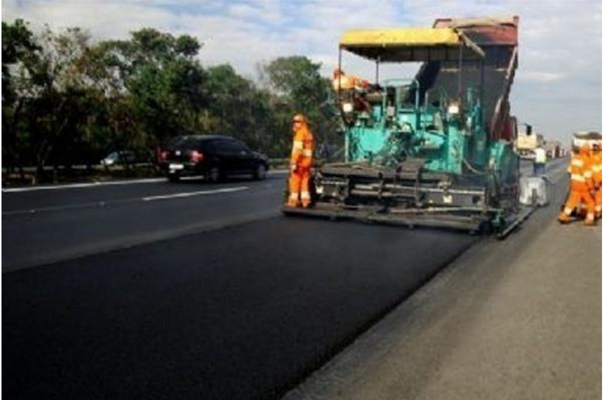
Figura 10. Recapeamento Rodovia dos Imigrantes, SP.
