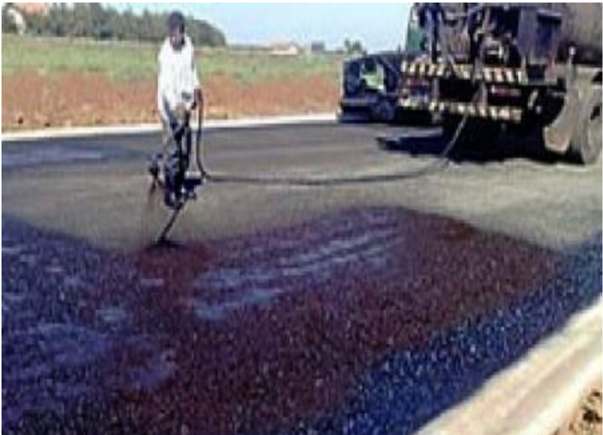
Figura 7. Pintura de Ligação.
