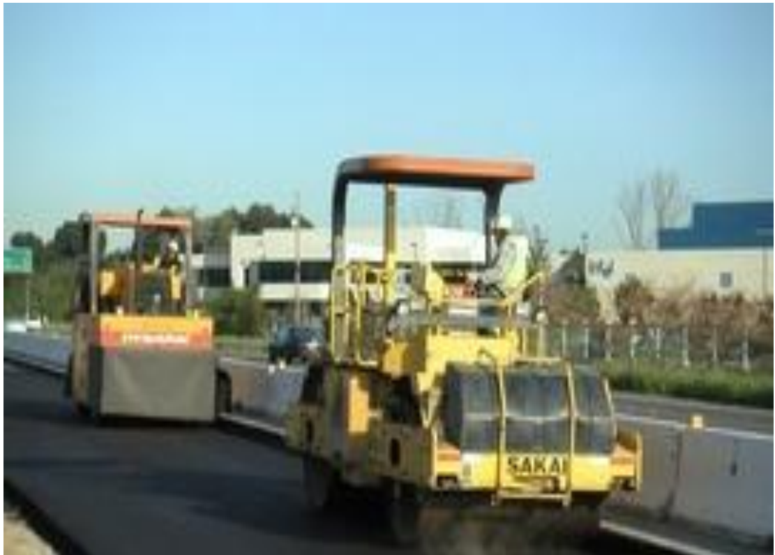
Figura 14. Rolos Pneumáticos compactando asfalto borracha. http://averdadedosfatos.com.br/noticia/savi-propoe-reutilizacao-de-pneus-na-construcao-de-asfalto
