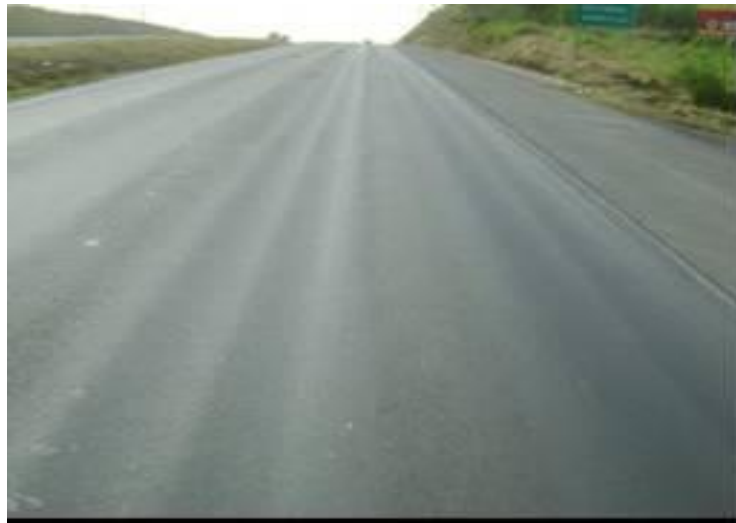
Figura 11. Deformação de trilhas de rodas.
