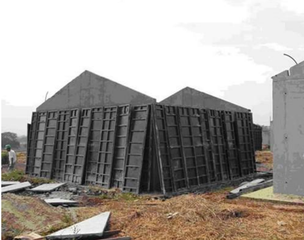
Figura 9 – Retirada das formas
