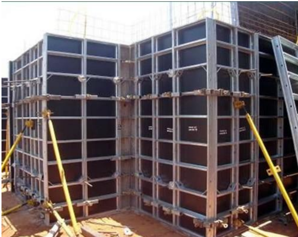
Figura 7 – Forma montada e pronta para concretagem
