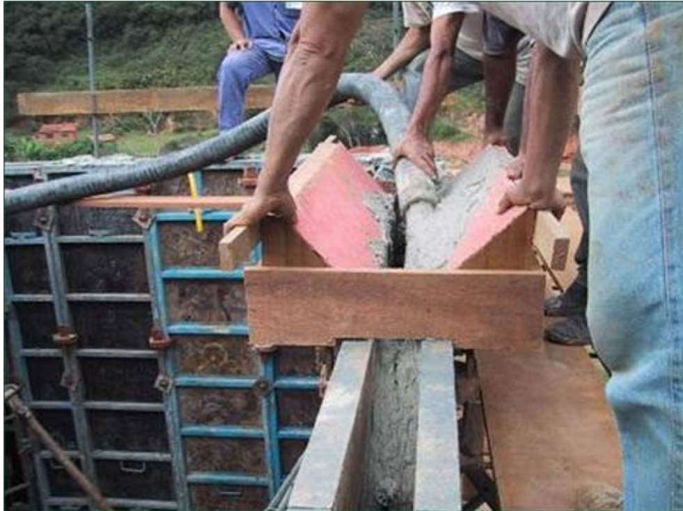
Figura 8 – Preenchimento das formas
