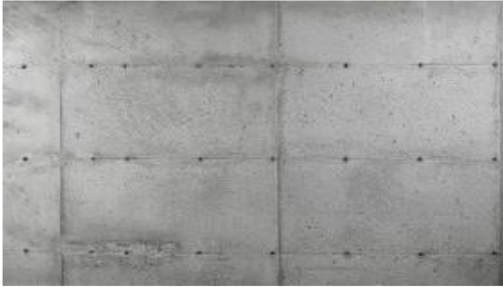
Figura 10 – Parede pronta para acabamento
