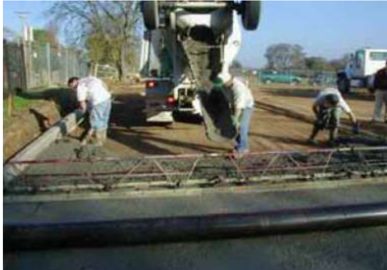
Figura 3: Procedimento de lançamento do concreto permeável (Fonte: YOUNGS, 2005.)
