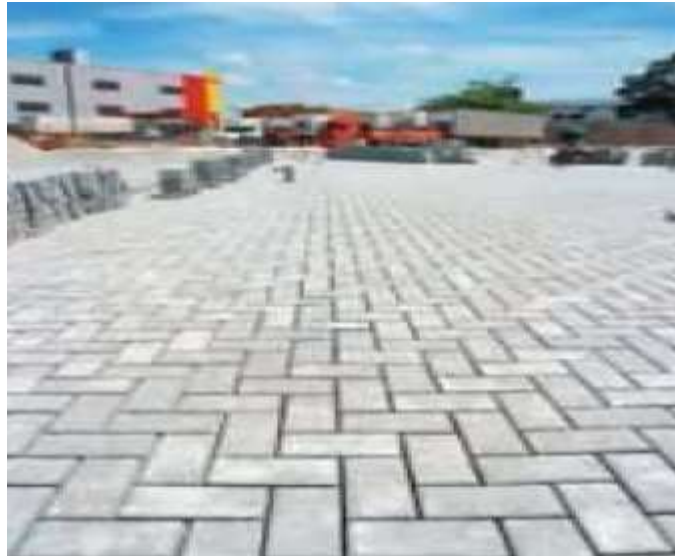
Figura 5: Pavimento permeável aplicado no porto de Itajaí-SC (Revista Prisma, 2005).
