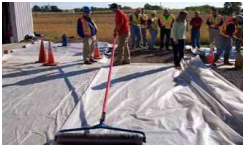
Figura 4: Passagem de rolo de metal transversal sobre a lona para retenção de umidade (Fonte: YOUNGS, 2005.)
