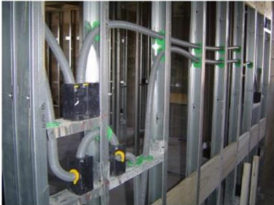
**Figura 07 - Tubulação Elétrica na Estrutura de Drywall**
