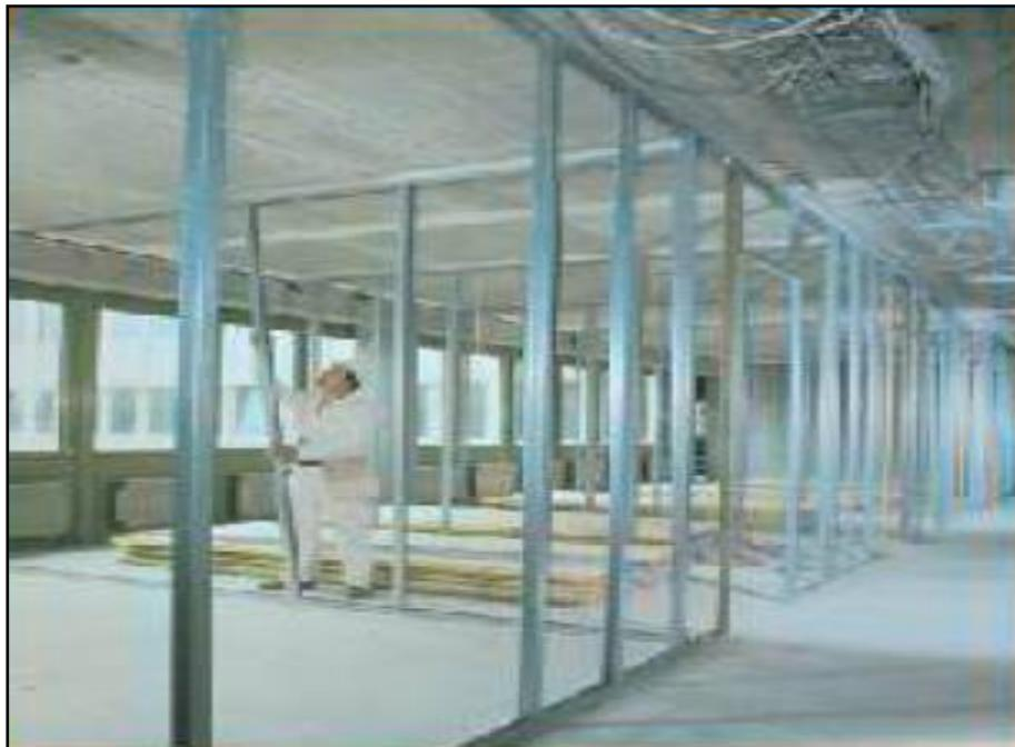
**Figura 05 – Marcação e fixação das guias**
