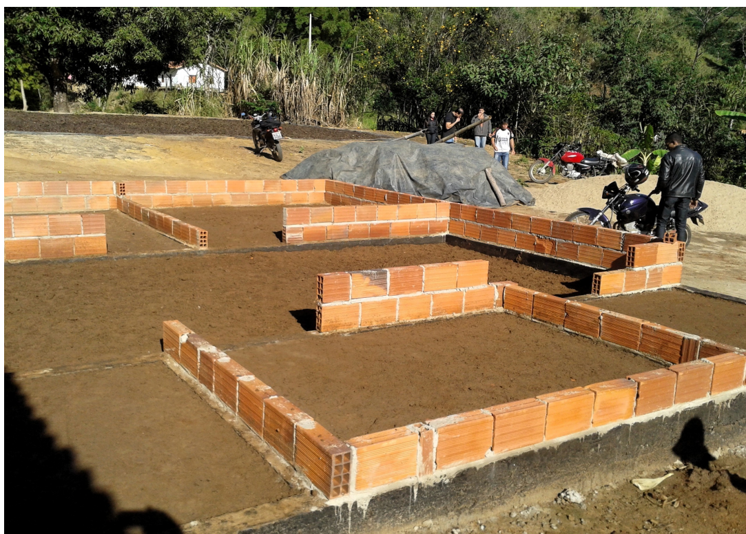
Figura 8- Fundação executada no distrito de Sapucaia – Ctga.
