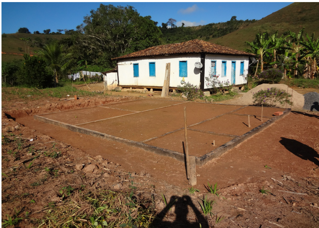
Figura 7- Fundação executada no distrito de Sapucaia – Ctga.
