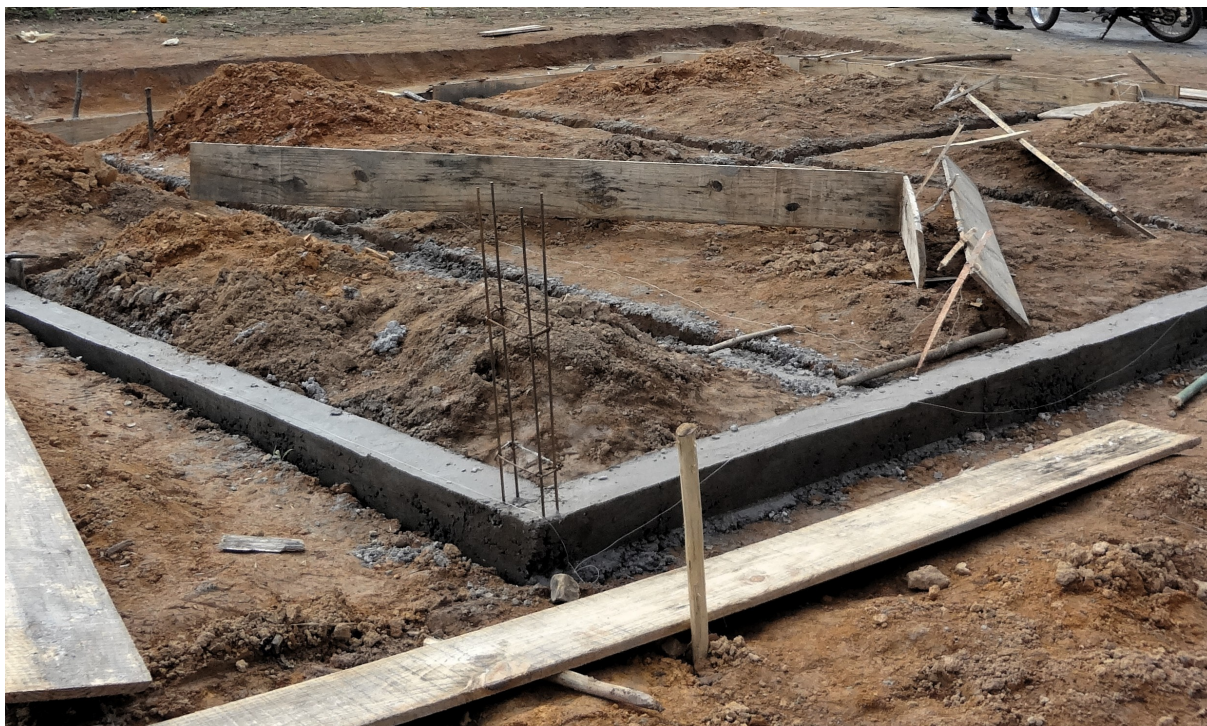
Figura 9- Fundação executada no distrito de Sapucaia – Ctga.
