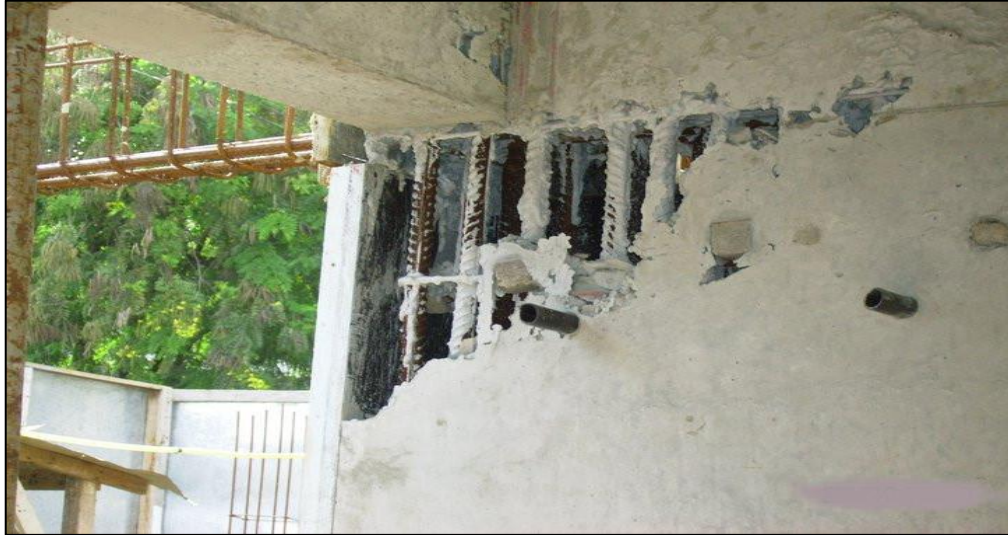
Figura 15 - Exemplo de nicho de concretagem
