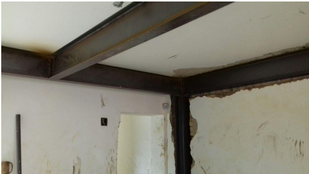
Figura 21 - Reforço com perfis metálicos
