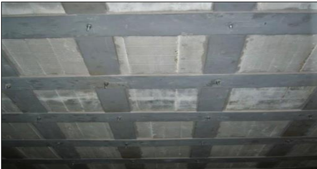
Figura 23 - Reforço de lajes com chapas metálicas com adesivo e parabol.
