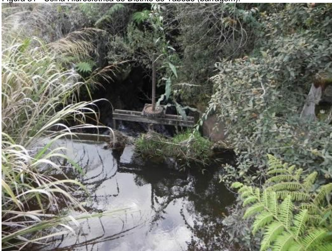
Figura 31 - Usina Hidroelétrica do Distrito de Taboão (barragem).
