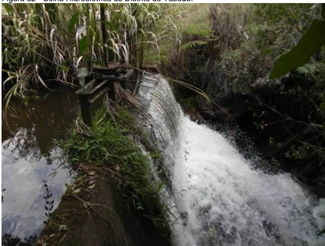
Figura 32 - Usina Hidroelétrica do Distrito de Taboão.
