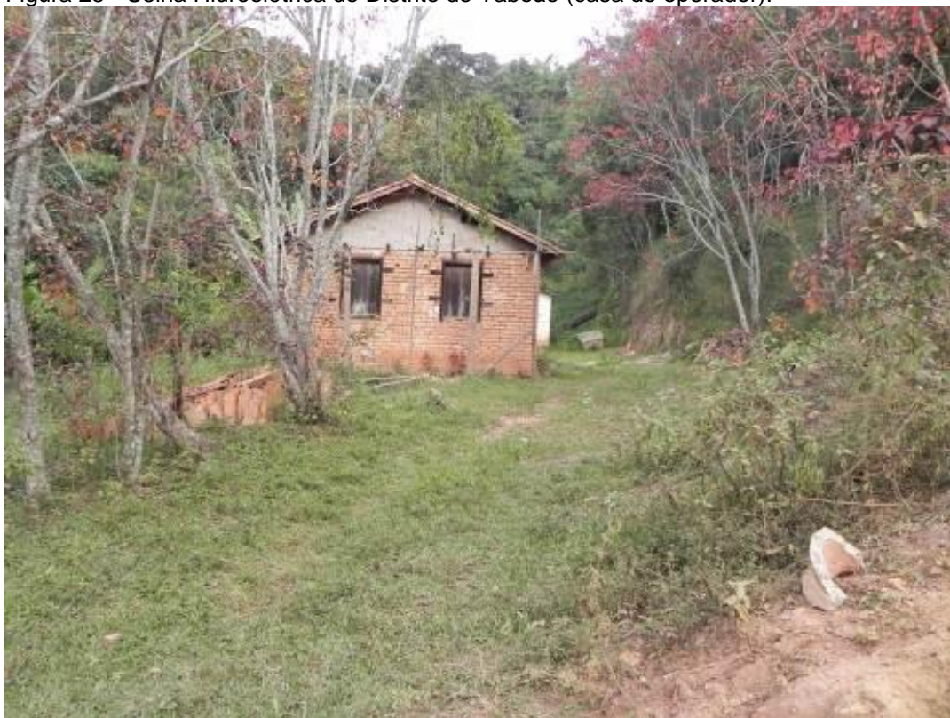
Figura 25 - Usina Hidroelétrica do Distrito de Taboão (casa do operador).
