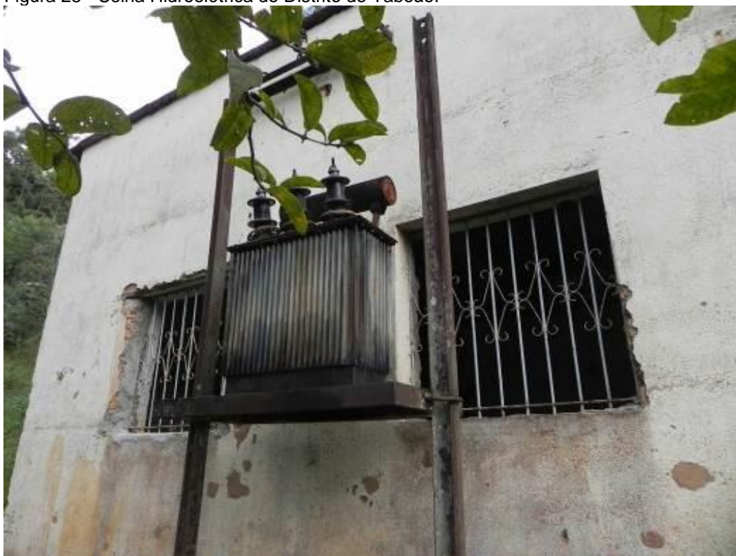
Figura 28 - Usina Hidroelétrica do Distrito de Taboão.
