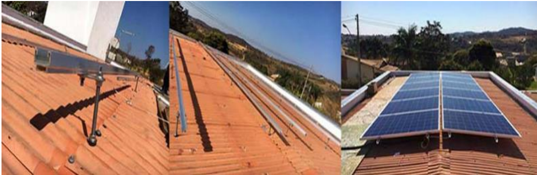
Figura 11 - Suporte para placas fotovoltaicas em telhados cerâmicos.
