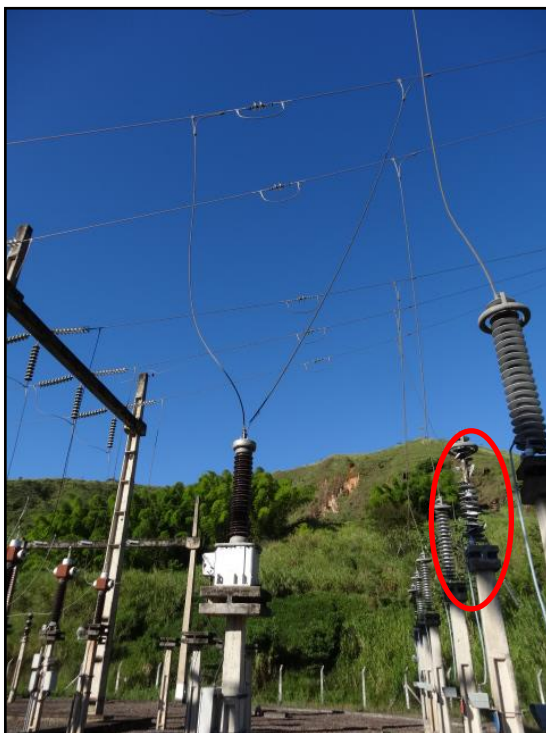
Figura 30 - Para-raios Fase B da LT JF A isolada pela concessionária CEMIG
