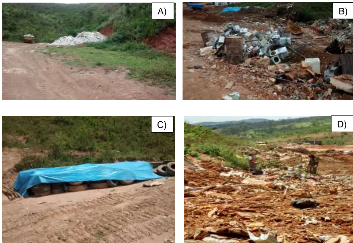
Figura 4. Resíduos sólidos irregulares encontrados no aterro em Grama, em Juiz de Fora – MG
