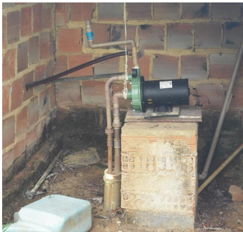
Figura 23 - Bomba que retira água subterrânea
