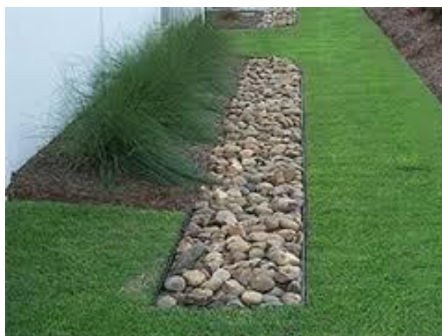
Figura 10 - Trincheira de infiltração pronta
