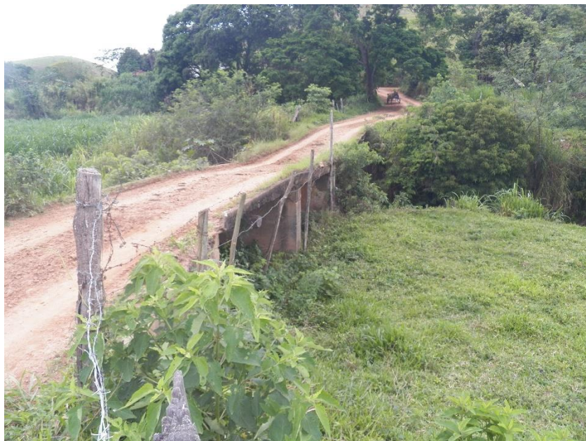
Figura 30 - Ponte próxima à chácara
