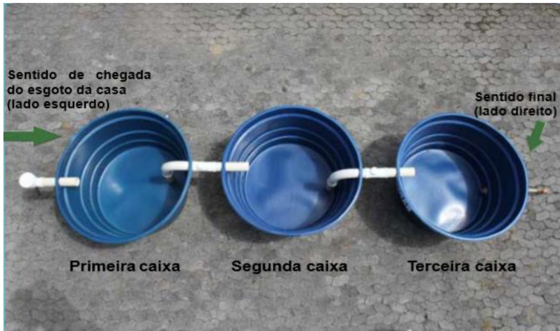
Figura 14 - Modelo de fossa séptica Embrapa
