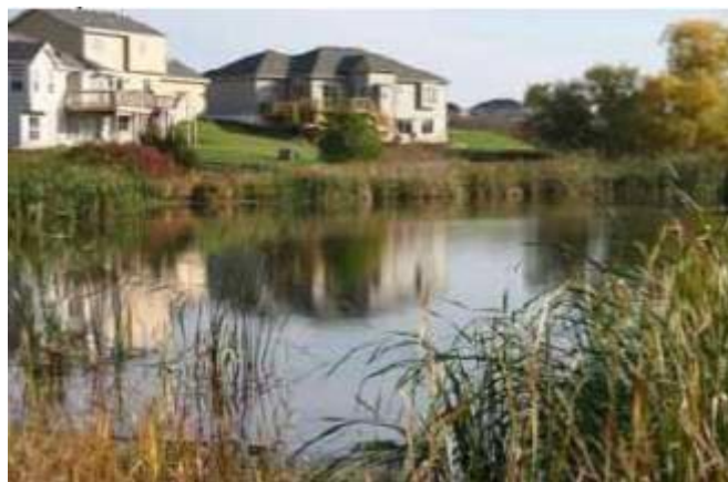
Figura 8 – Reservatório de retenção em bairro residencial
