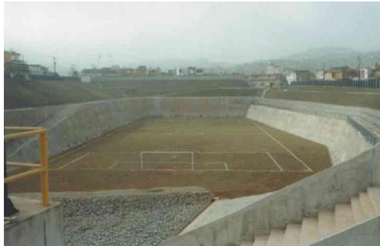
Figura 7 - Reservatório de retenção em São Bernardo do Campo
