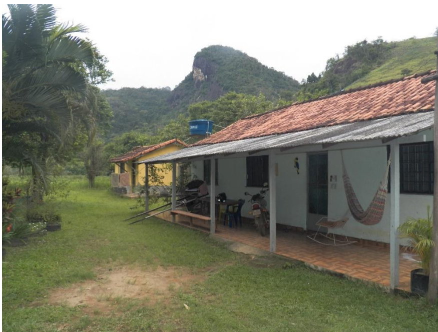
Figura 27 - Construções (casas) da chácara
