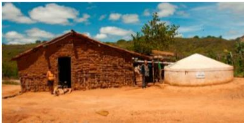
Figura 5 - Cisterna instalada pelo P1MC Fonte: Agência Fiocruz (apud Campos 2017)
