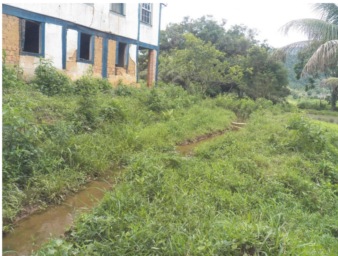
Figura 43 - Córrego antes de chegar à chácara
