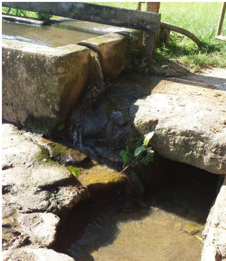
Figura 25 - Caminho da água do córrego para o açude
