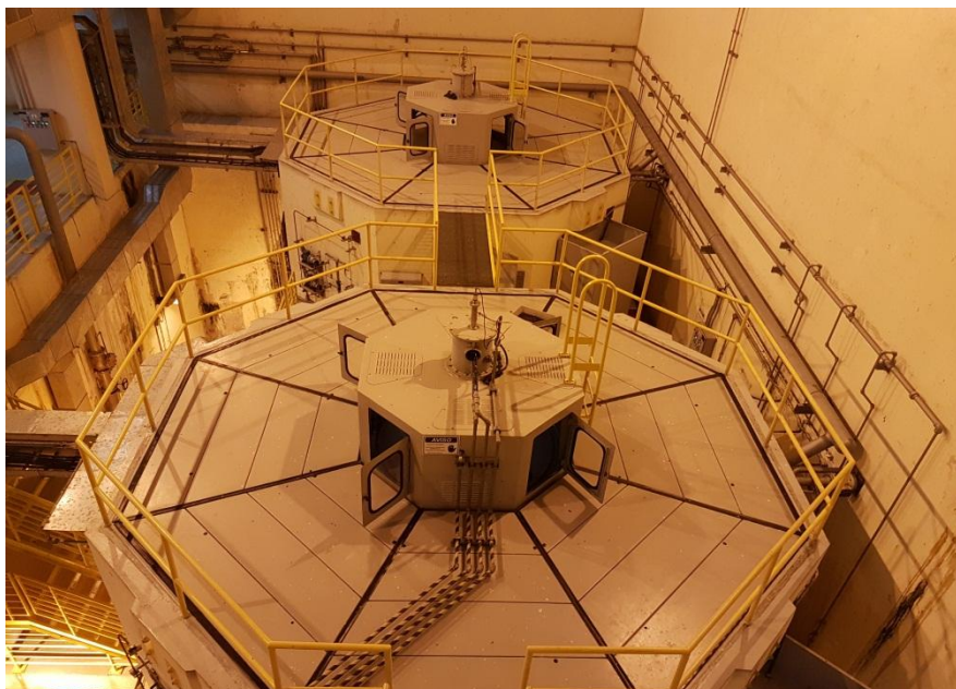
Figura 11: Geradores Síncronos da PCH Areia Branca
