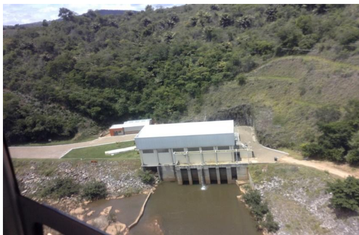
Figura 9: Casa de Força e Canal de Fuga
