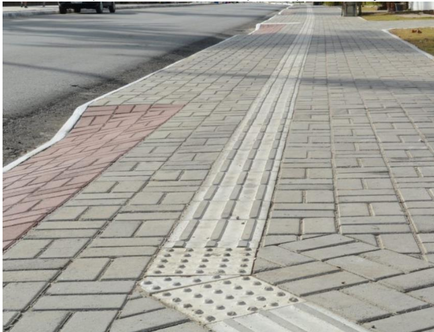
Figura 122 – Piso podotátil como exemplo de pavimentação da calçada
