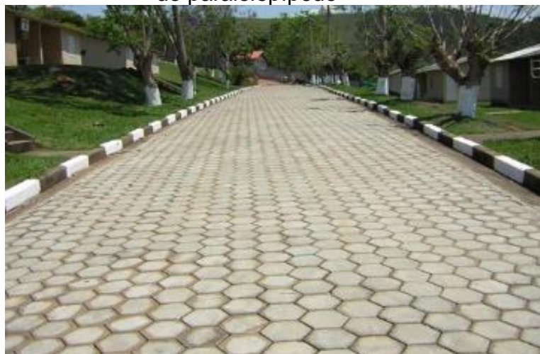
Foto 163 – Exemplo de rua pavimentada com piso inter travado de paralelepípedo
