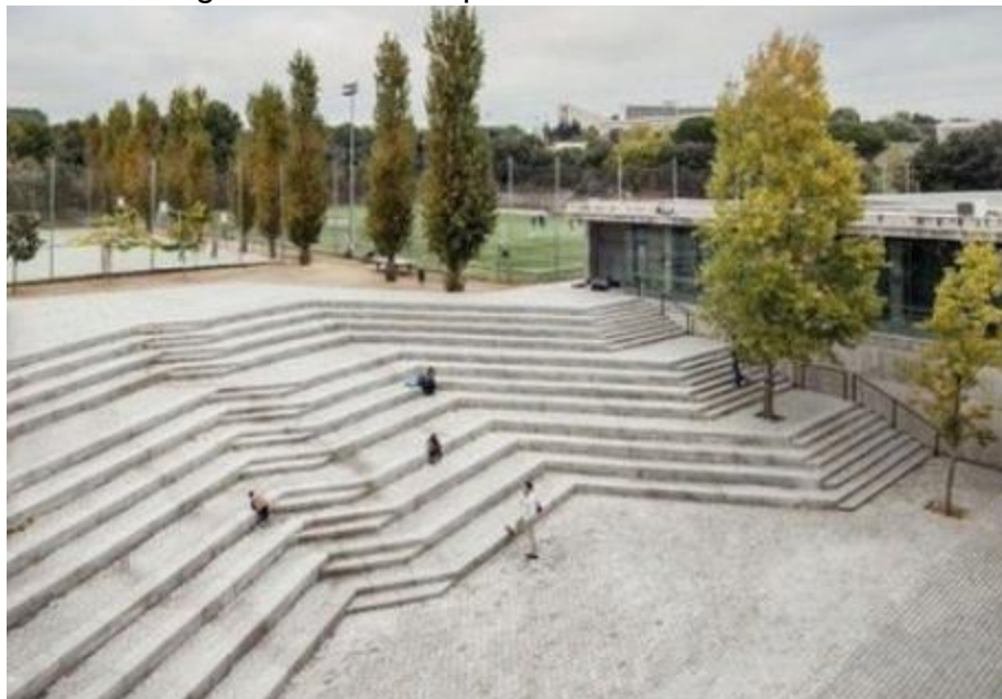
Figura 140 – Exemplo de escada de acesso
