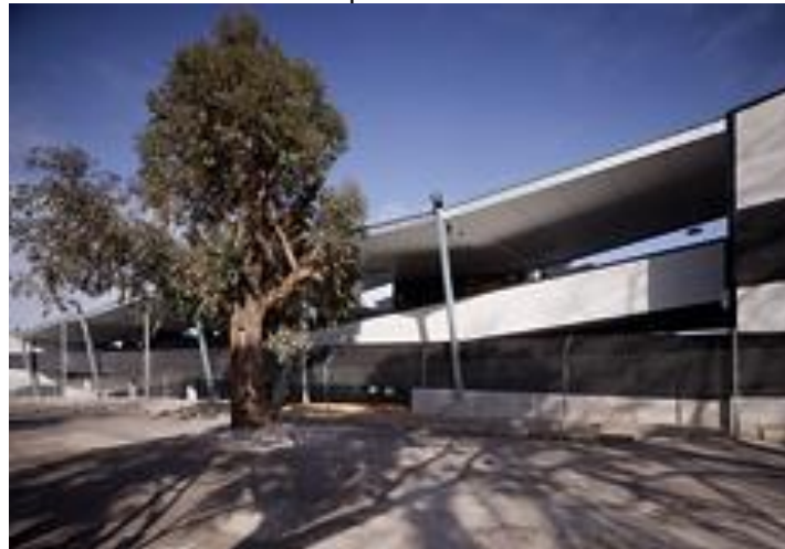
Figura 85 – A borda leste inclinada do prédio fornece acesso às cinco alas dos canis.
