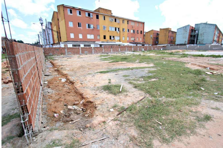
Figura 101 – Terreno onde será construído o hospital veterinário
