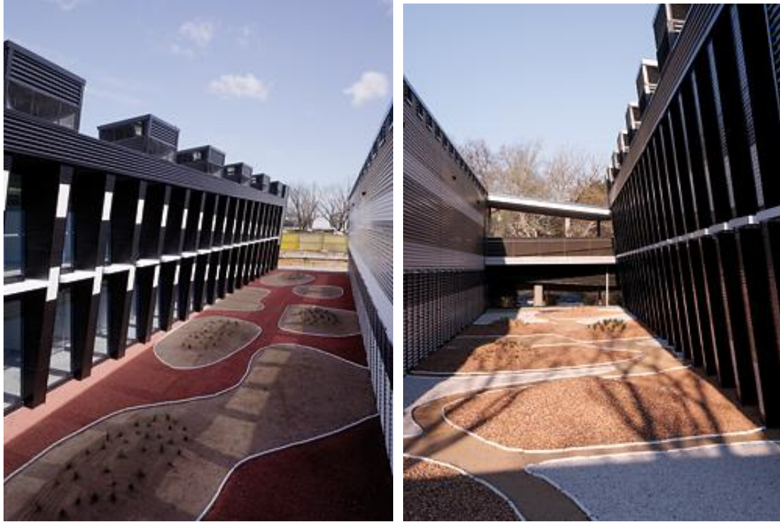
Figura 79 – Pátio central possuindo piso externo com vários esquemas táteis para auxiliar na reabilitação de cães
