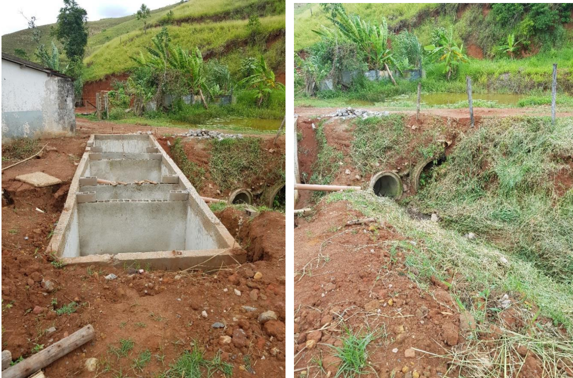
Figura 60 – Esgoto passando pelo Terreno do Canil Municipal
