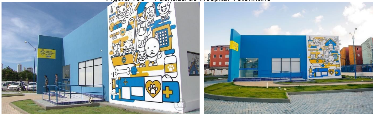
Figura 100 – Fachada do Hospital Veterinário
