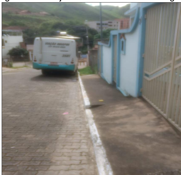
Figura 10 - Calçada desnivelada e com degrau
