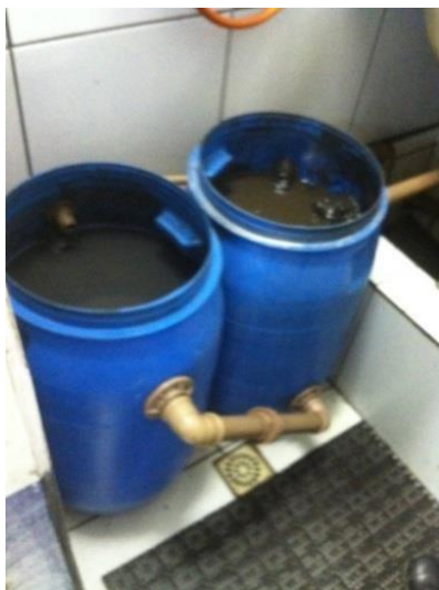
Figura 01: Caixa separadora
