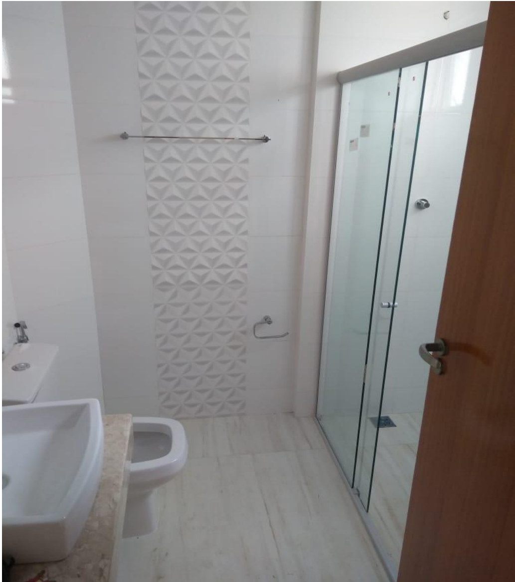
Figura 4: Vista parcial do banheiro da suíte
