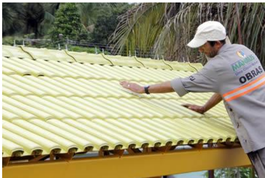
Figura 2.8 Telha de Pet
