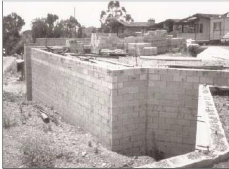
Figura 15: Muro de contenção em alvenaria estrutural
