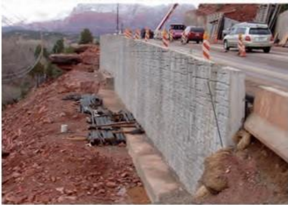
Figura 14: Muro de concreto armado em execução
