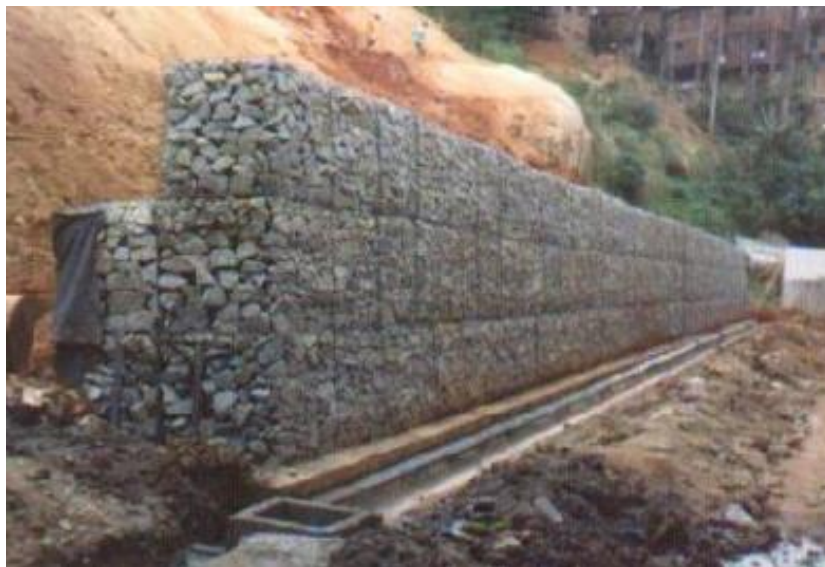
Figura 19: Muro construído em gabião
