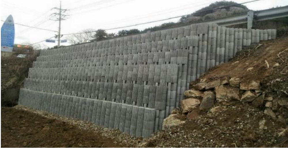
Figura 22: Muro executado em Logblock
