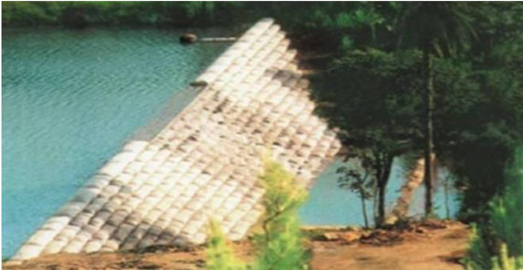
Figura 20: Muro de contenção com sacos solo-cimento
