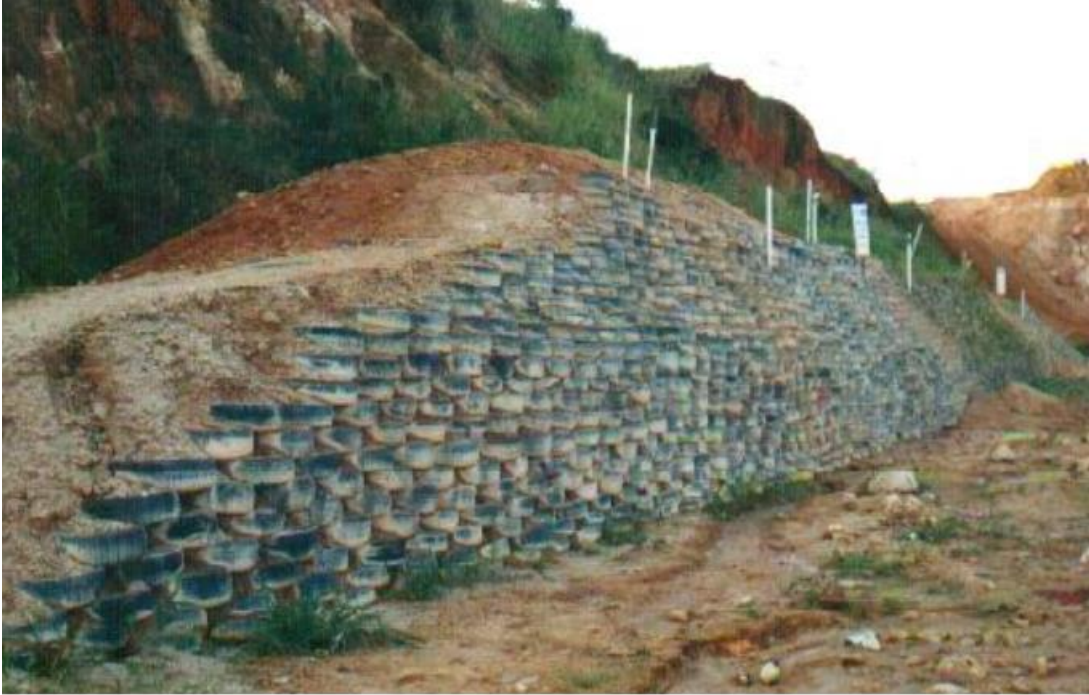
Figura 21: Muro de solo-pneus
