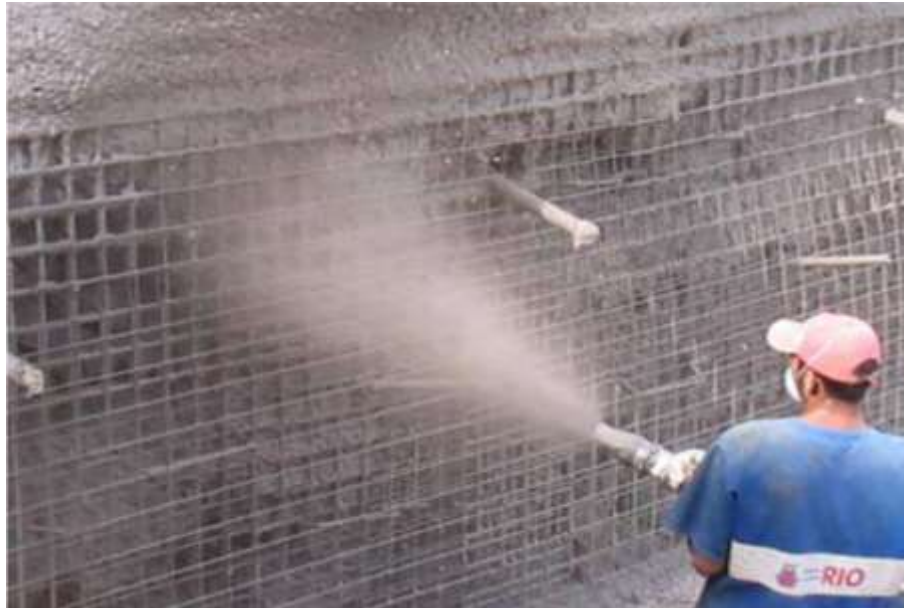
Figura 9 - Aplicação de concreto projetado sobre superfície de talude com tela soldada
