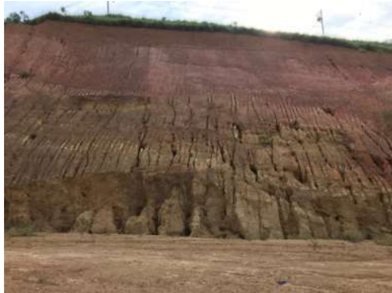
Figura 19 - Talude do estudo
