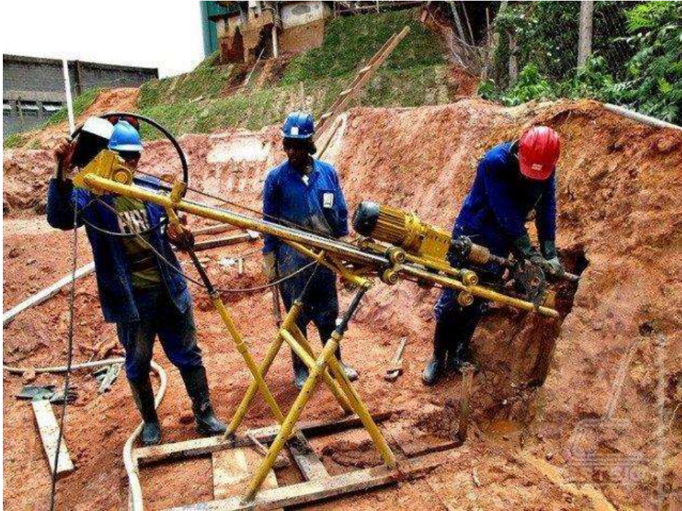
Figura 8 - Perfuração do solo grampeado
