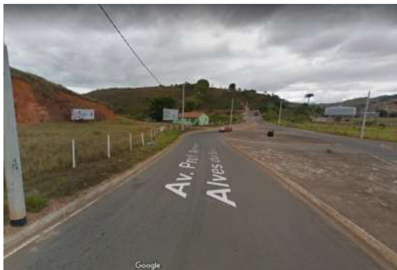
Figura 20 - Localização do talude
