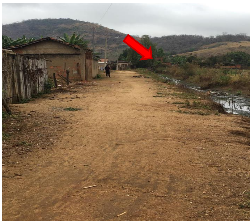
Figura 11 – Esgoto ao céu aberto em divisa com a rua
