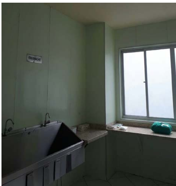
Figura 24: Vidro jateado precavendo insolação (Centro Obstetrício)
