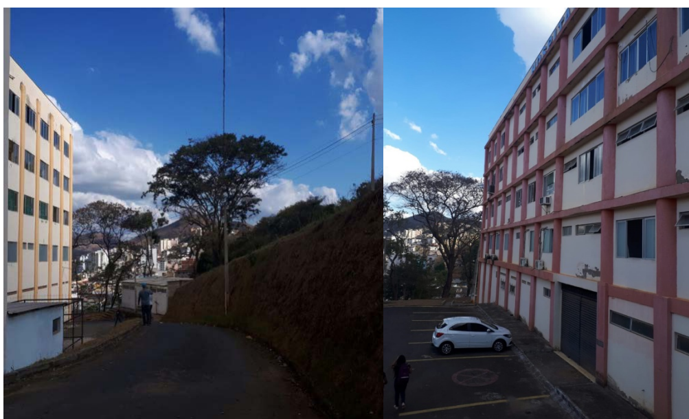
a) Fachada oeste
