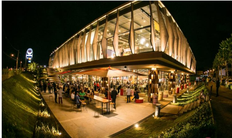
Figura 31: Fachada Mercado Boca, Nova Lima - MG, s/ data disponível em: https://mercadodaboca.com.br/o-mercado/ Acesso em: 17/10/2019 às 15:29.
