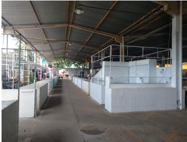
Figura 26: Corredor interno do galpão, arquivo autoral, 15/11/2019 às 14:58.
