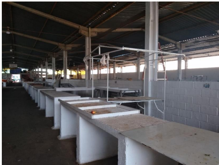
Figura 27: Corredor interno do galpão, arquivo autoral, 15/11/2019 às 15:00.
