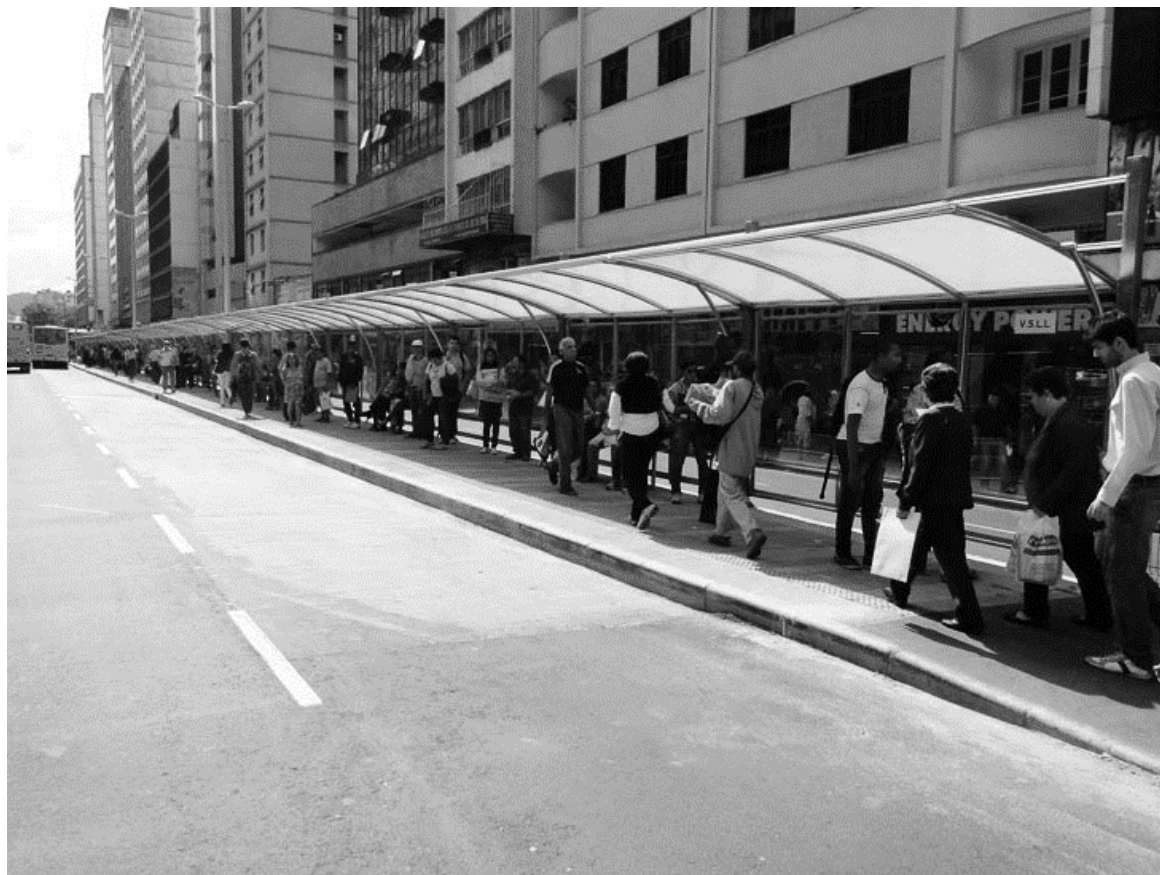
Figura 42 - Abrigo para parada de ônibus área 03 de estudo, Av. Rio Branco
