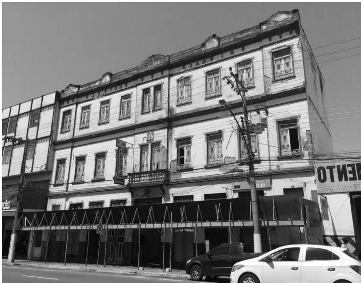
Figura 25 - Edifício tombado em estado de degradação na Av. Francisco Bernardino
