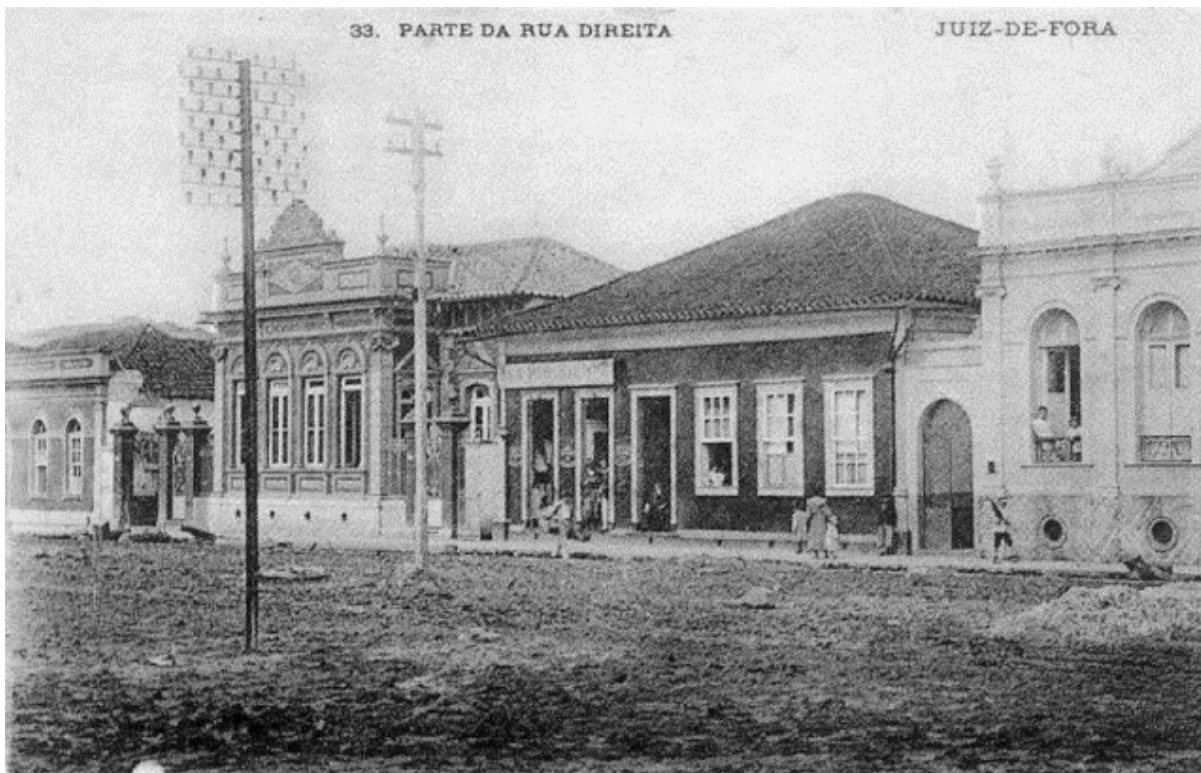
Figura 7 - Rua Direita atual Av. Rio Branco
