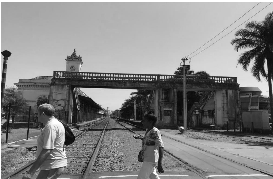
Figura 24 - Travessia de pedestres pela linha férrea na Praça da Estação
