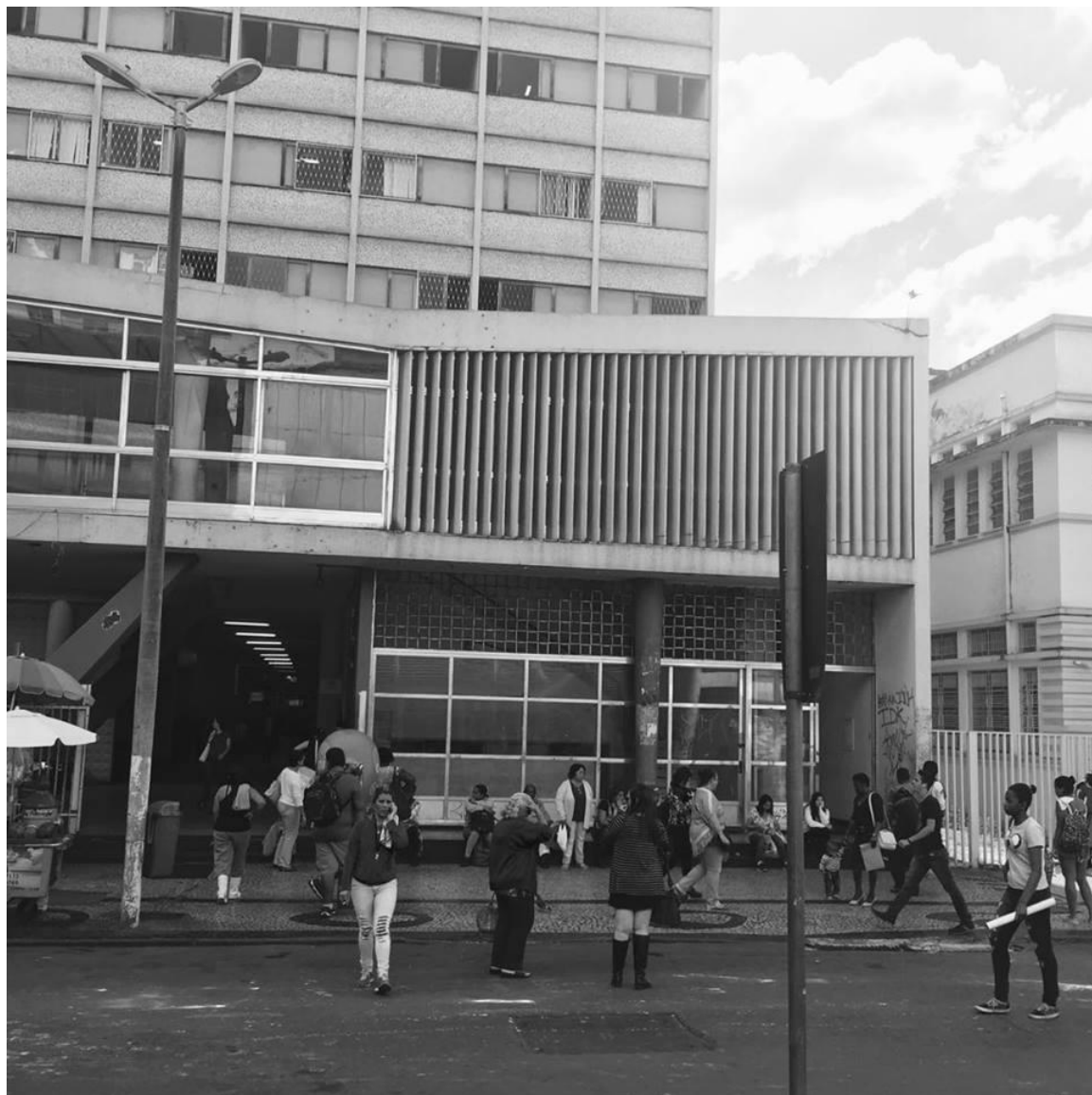
Figura 30 - Ed. Pam Marechal, Rua Marechal Deodoro
