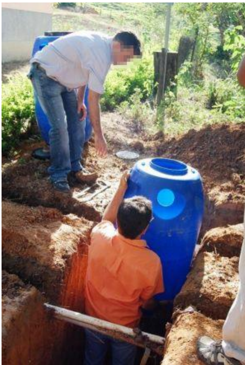
Figura 6 - Implantação de fossa séptica econômica na zona rural Dom Lara distrito de Caratinga/MG.
