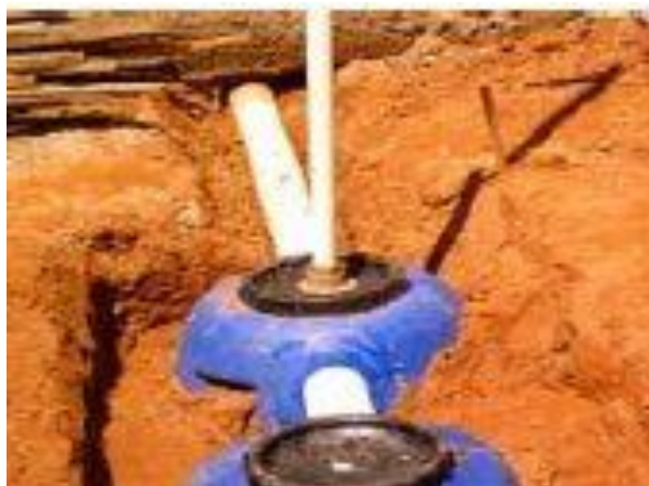
Figura 40 - Suspiro para saída dos gases.
