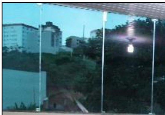
Figura 30: Aberturas na janela
