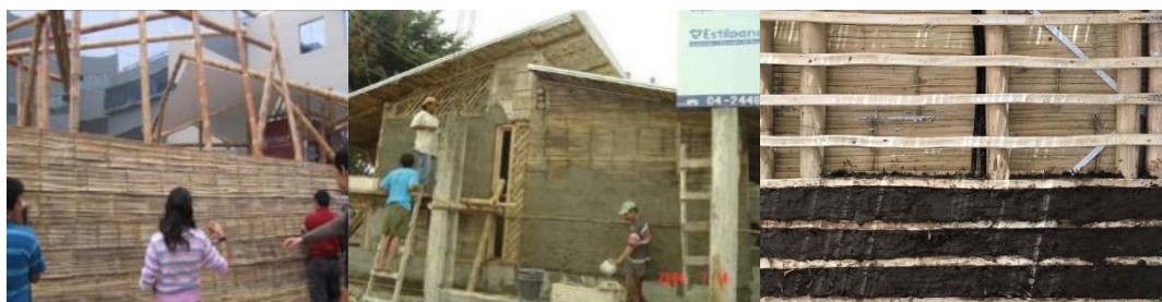
Figura 58 Paredes com esteiras de bambu e reboco de solocimento e a direita de terra
