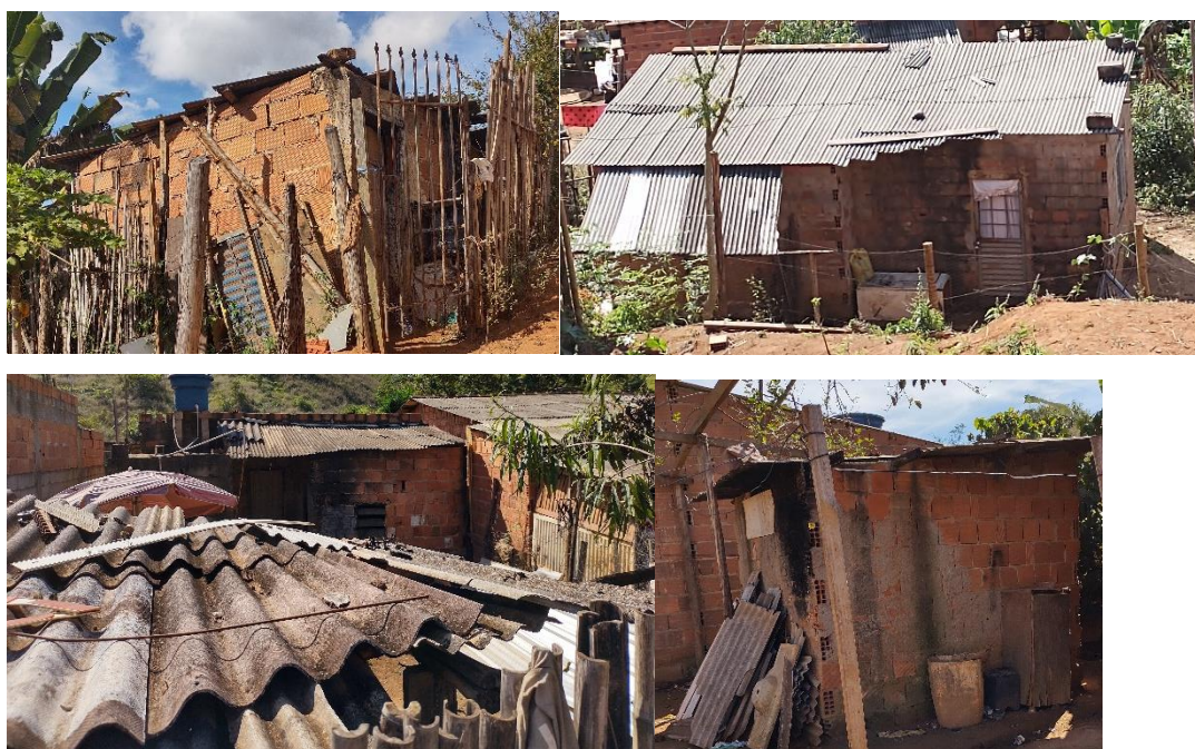
Figura 43 Imagem dos telhados
