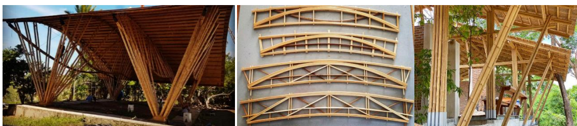
Figura 66 imagens de telhados
