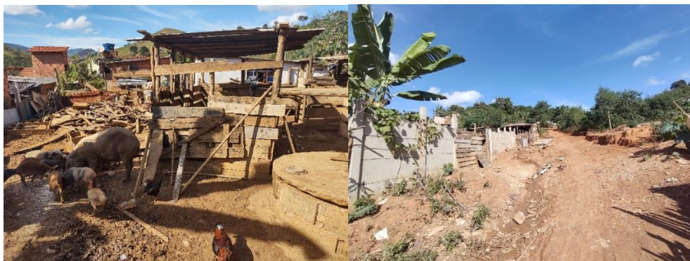
Figura 35 Pocilga com escoamento inadequado dejetos na rua
