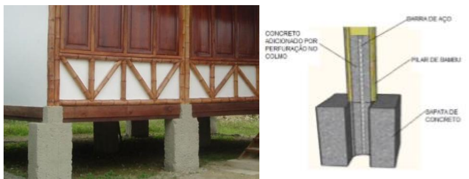
Figura 53 Estrutura de sapata e pilar com concreto em bambu
