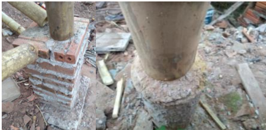
Figura 52 Estrutura de sapata e pilar
