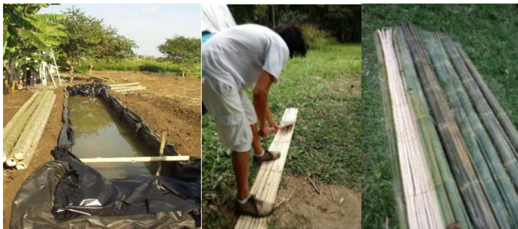
Figura 47 Vala de tratamento e corte para as esterilhas
