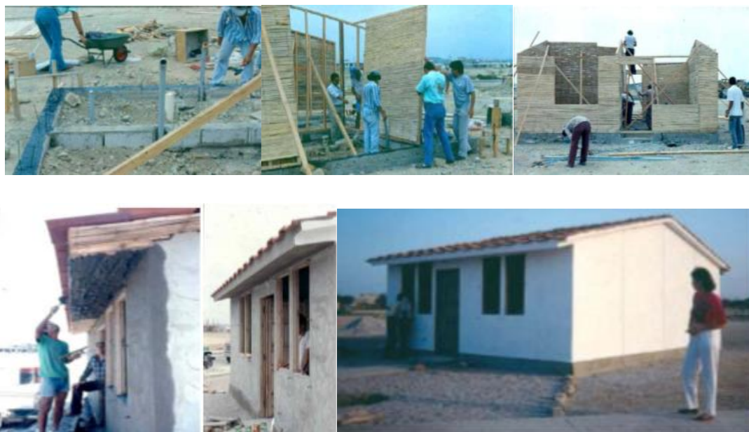
Figura 75 Processo de construção da Vivenda
