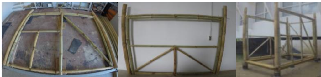
Figura 54 Painéis montados em oficina e posteriormente levado para o local do experimento
