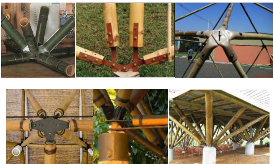
Figura 20 Conexão Renzo Piano, no meio Mark Motimer e à direita conectores de plástico, abaixo exemplos de conexões metálicas Leiko Hama Motomura e Cláudio Maia
