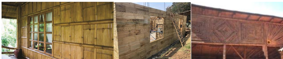
Figura 59 Paredes com esteiras aparentes
