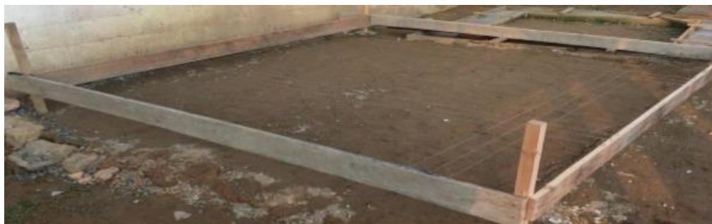
Figura 48 Marcação do gabarito para a construção
