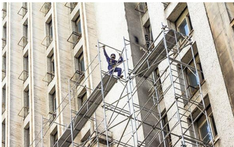
Figura 10: Retrofit de fachada.
