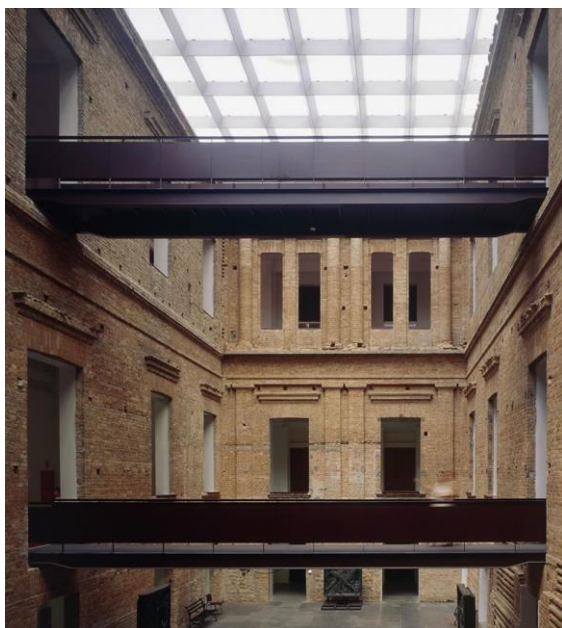
Figura 48 – Det. vãos abertos do pátio central.
