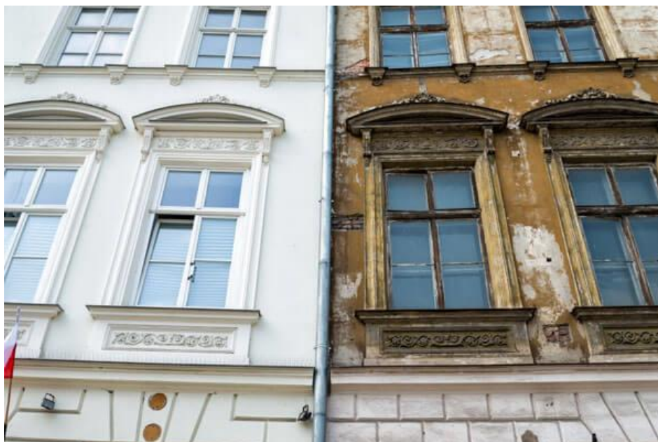
Figura 9: Retrofit de fachada.
