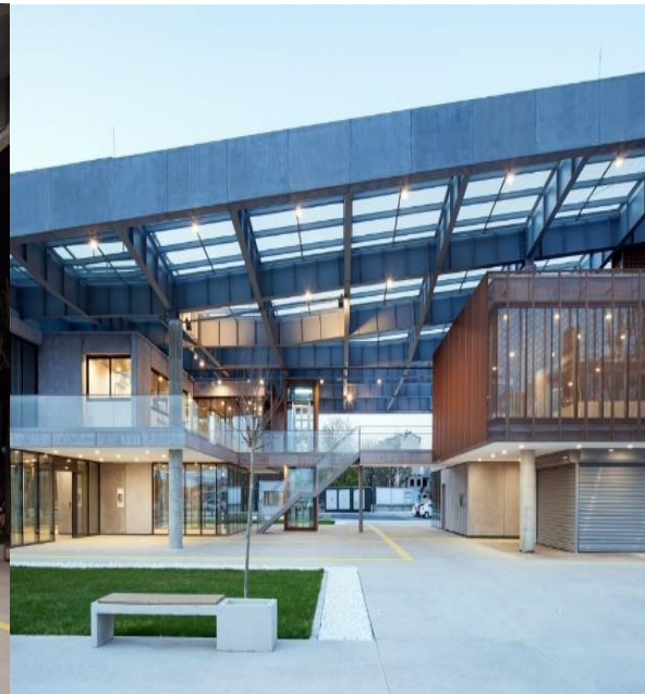
Figura 31 – Cobertura inclinada/ Vista lateral.
