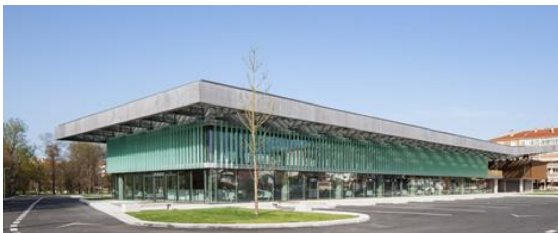
Figura 37 – Brises verticais para contenção solar.
