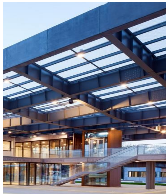
Figura 35 – Circulação vertical escada lateral e elevador.
