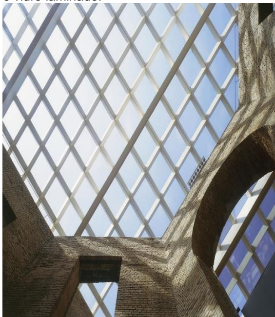
Figura 46 – Detalhe da cobertura em perfis de aço e vidro laminado.
