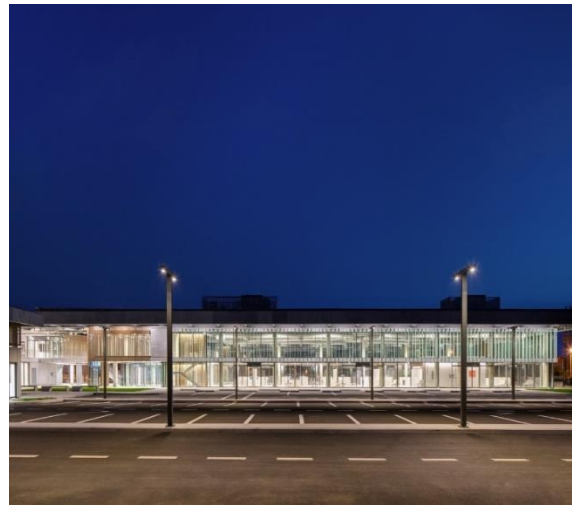
Figura 33 – Iluminação externa do terminal.
