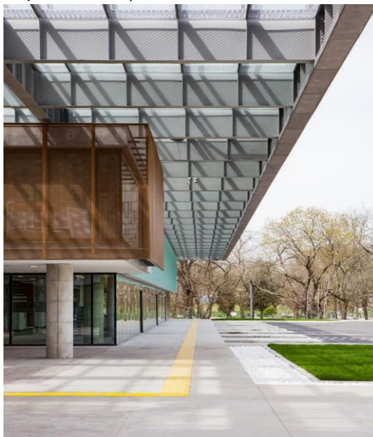
Figura 34 – Cobertura metálica e fechamento de paredes em pele de vidro.
