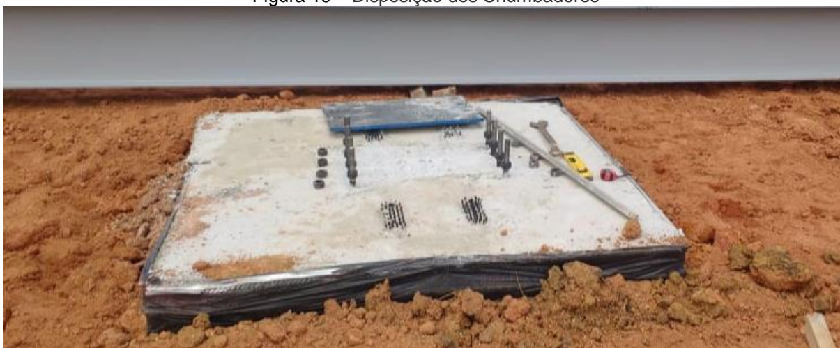
Figura 19 – Disposição dos Chumbadores
