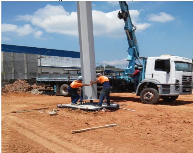
Figura 24 – Travamento do pilar
