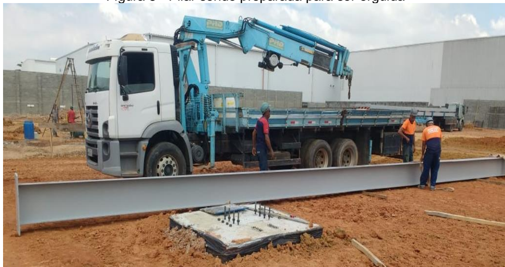
Figura 8 - Pilar sendo preparada para ser erguida
