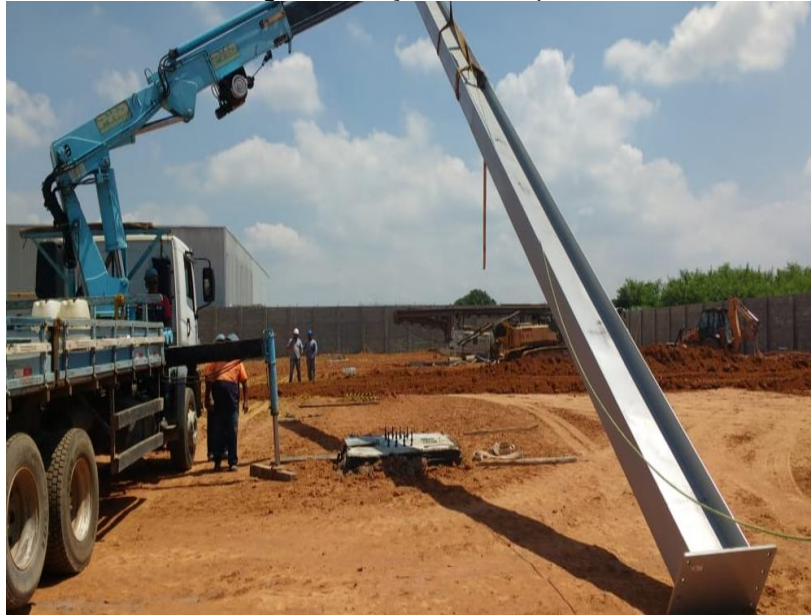
Figura 23 – Içamento do pilar
