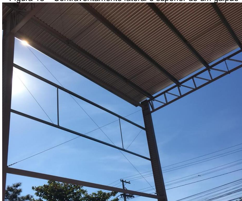
Figura 13 – Contraventamento lateral e superior de um galpão
