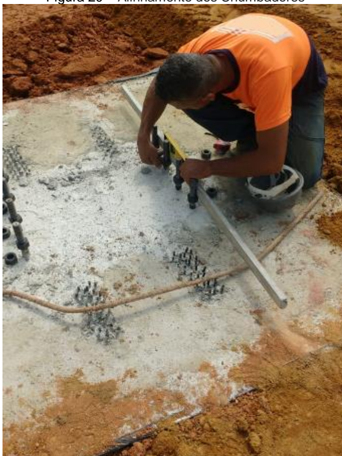
Figura 20 – Alinhamento dos Chumbadores
