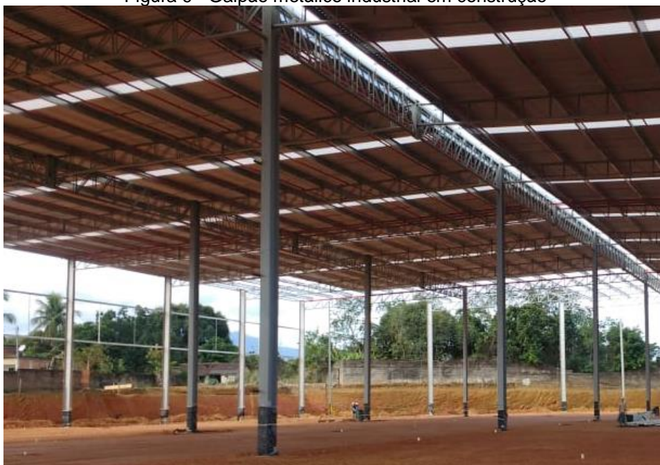
Figura 9 - Galpão metálico industrial em construção
