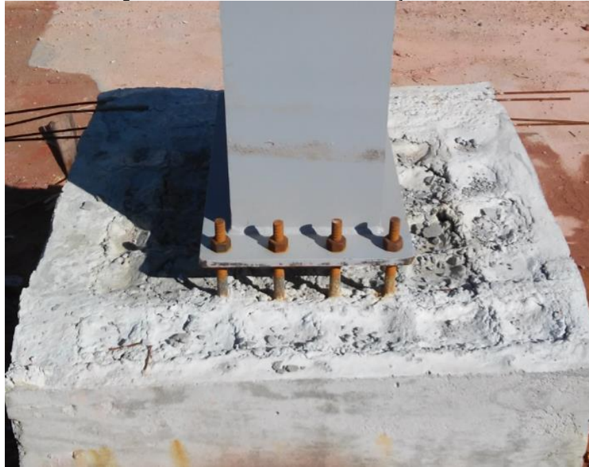
Figura 7 - Parabolts fixados a fundação
