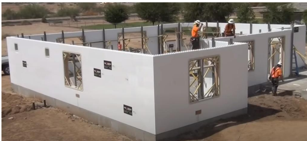
Figura 6: Paredes esquadrejadas prontas para concretagem
