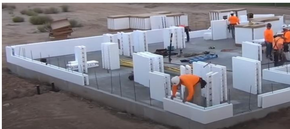
Figura 5: Fundação e primeira fiada
