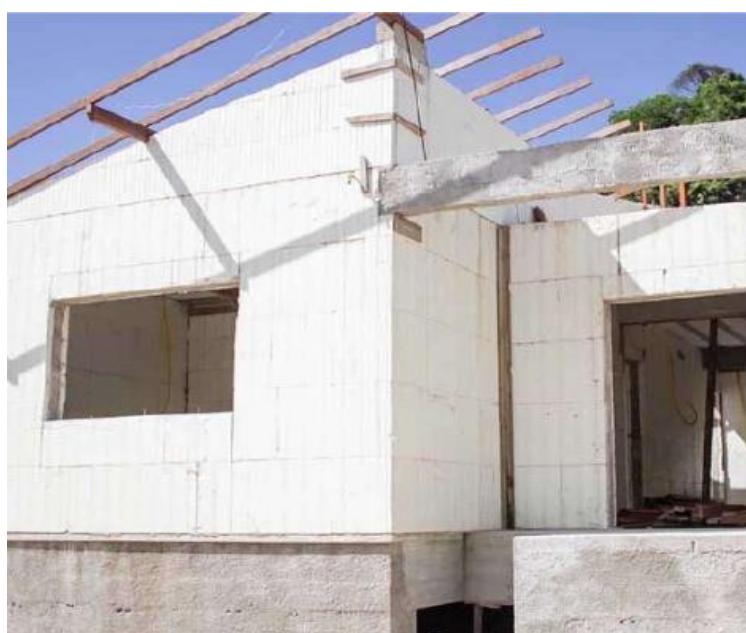
Figura 9: Estrutura da cobertura montada
