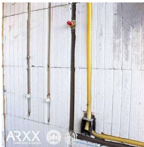
Figura 7: Corte para instalação elétrica e hidráulica
