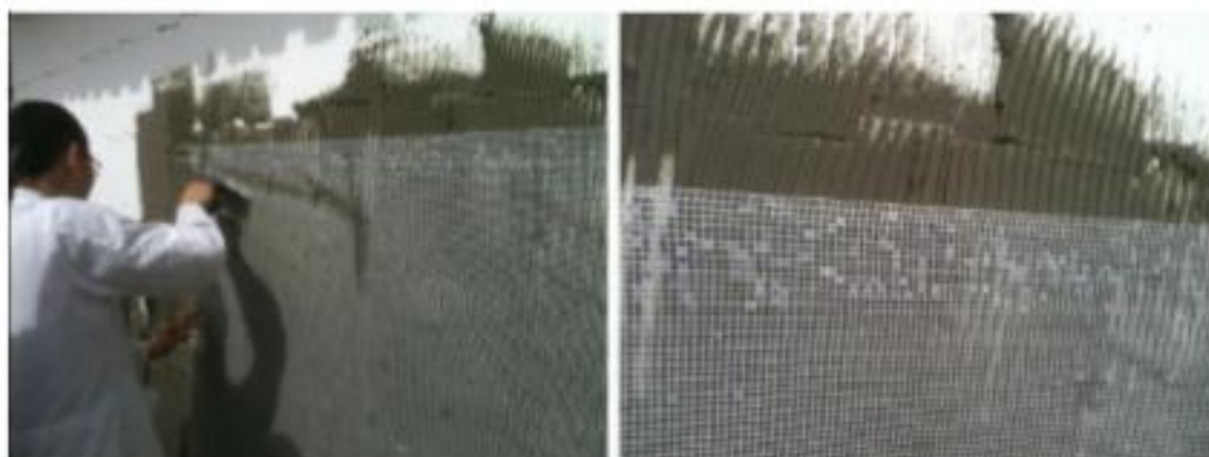
Figura 8: Revestimento de formas
