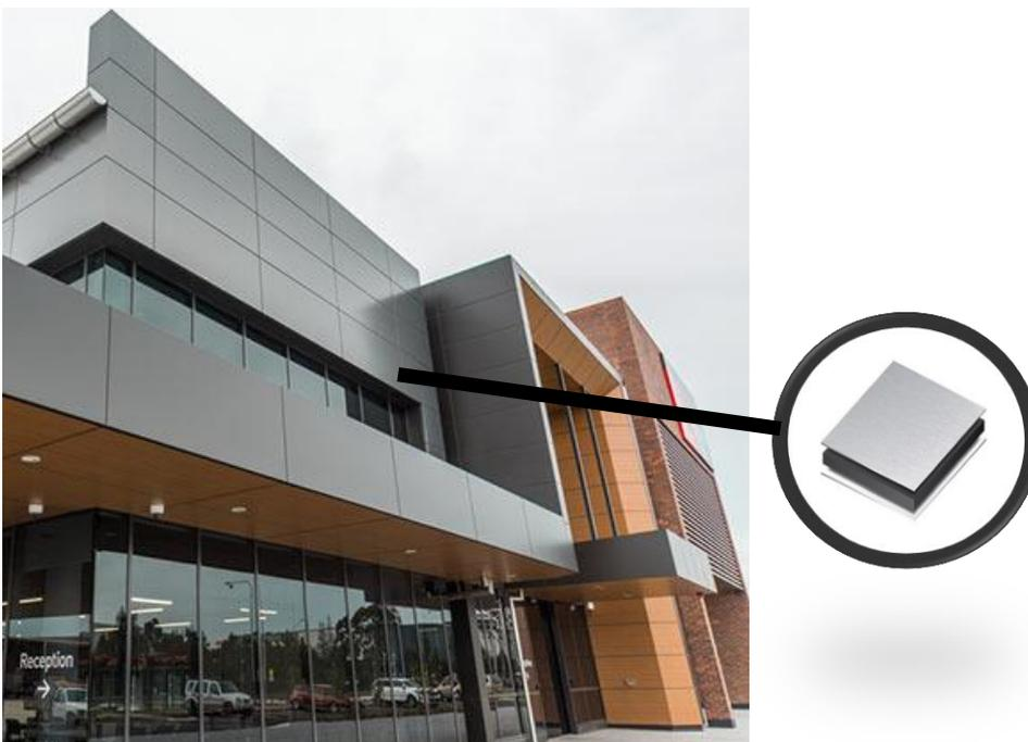
Figura 97: Edificação com uso de revestimento em alucobond na fachada- Disponível em: Fonte: <https://www.tomark.com.au/> / Acessado em 02/06/20
