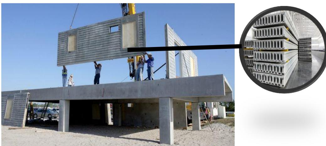
Figura 95: Edificação de estrutura pré-fabricada- Disponível em: Fonte: <https://www.mapadaobra.com.br/inovacao/pre-moldados-e-pre-fabricados/> Acessado em 02/06/20
