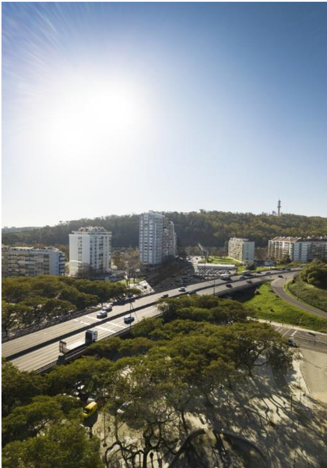
Figura 43: Vista Aérea do Viaduto na Praça Fonte Nova.
