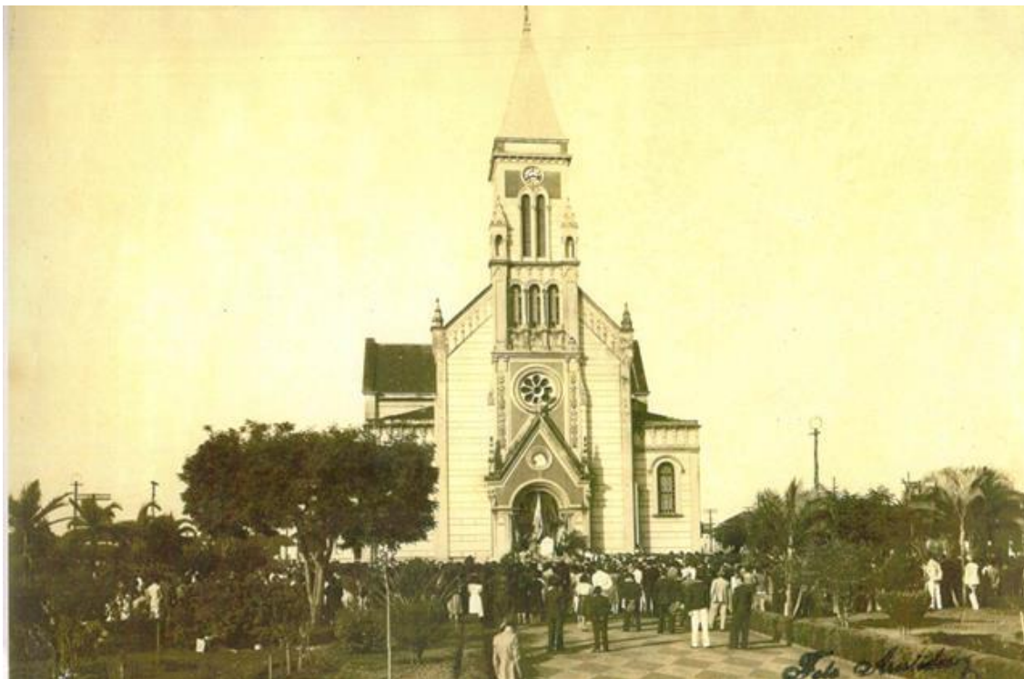
Figura 27: Igreja Matriz de São Domingos no ano de 1945 – Praça da Matriz.
