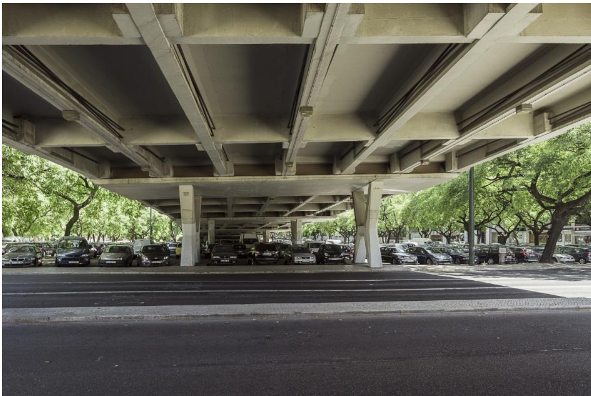
Figura 44: Vista de baixo do Viaduto na Praça Fonte Nova.
