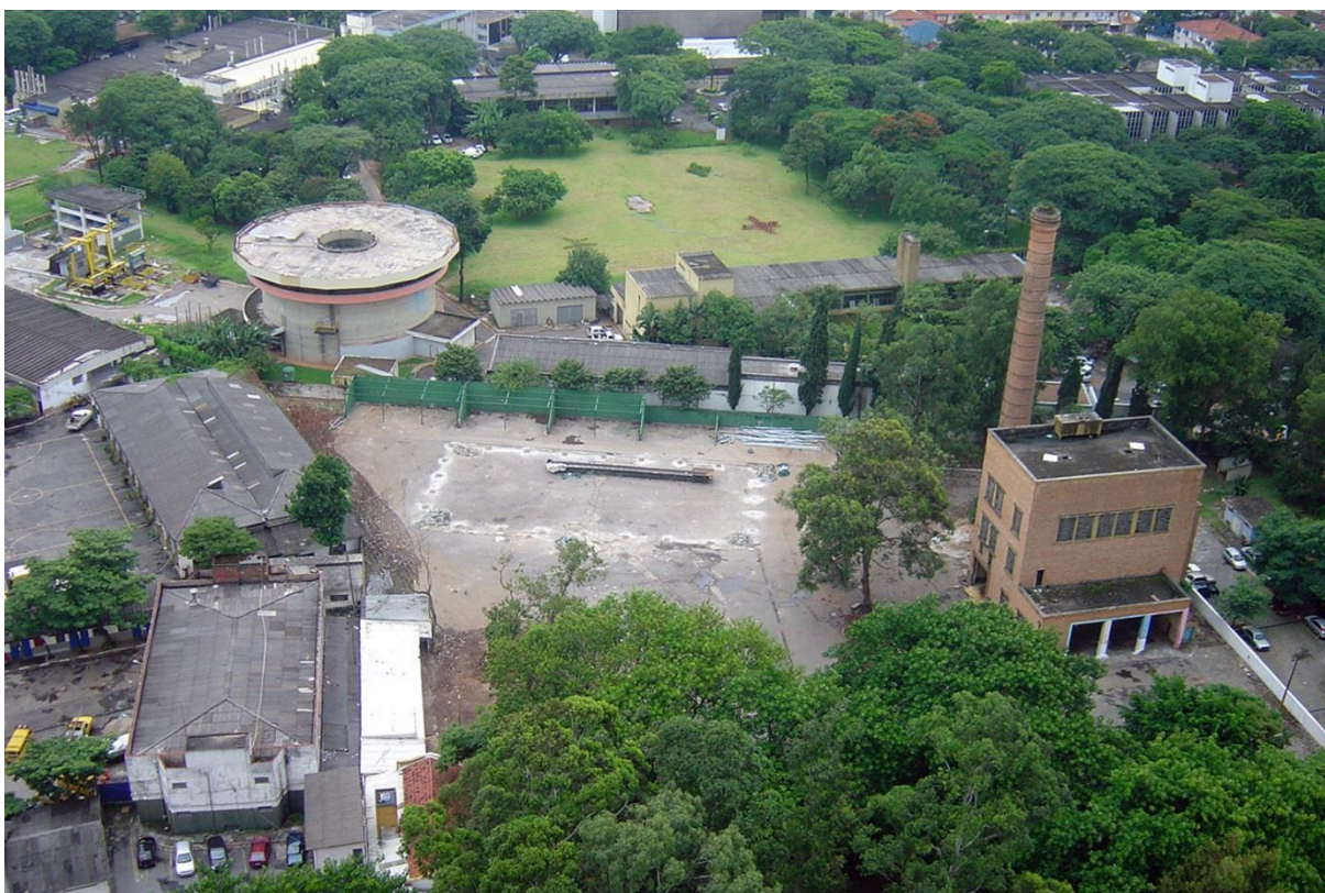
Figura 56: Incinerador Pinheiros – Terreno onde foi construída a praça.
