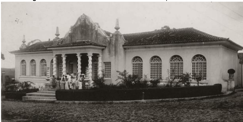
Figura 3: Fachada do Pavilhão Feminino do Hospital Colônia.
