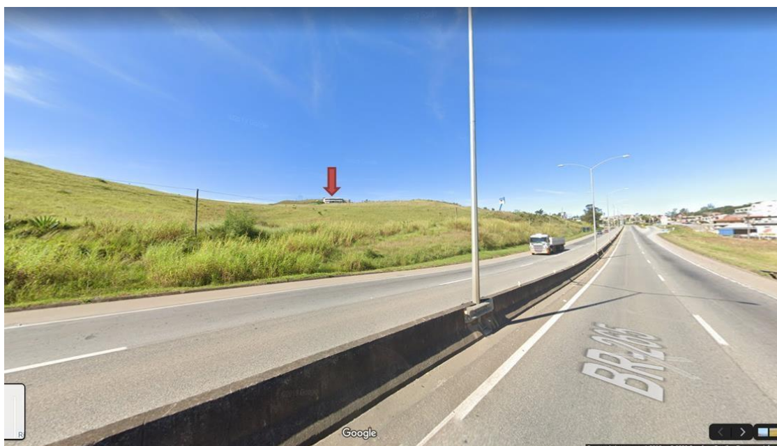
Figura 44: Vista do terreno na Rodovia BR-040 – Brasil.
