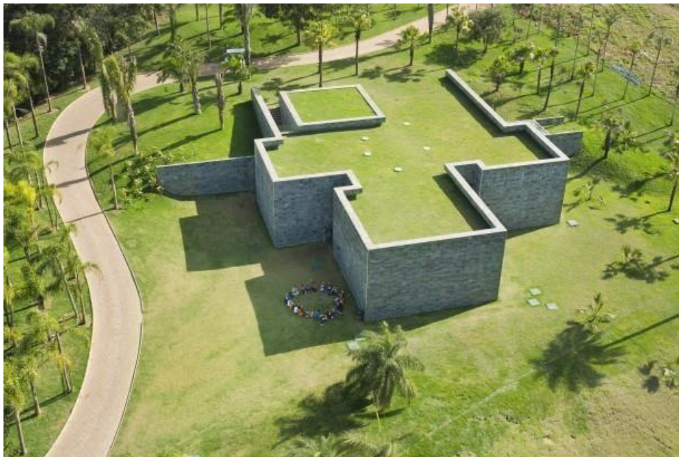
Figura 19: Vista superior da galeria e a continuidade do terreno proporcionado pela cobertura verde.
