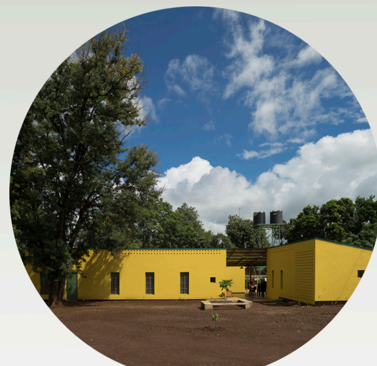
CASA ALBERGUE KWIECO
