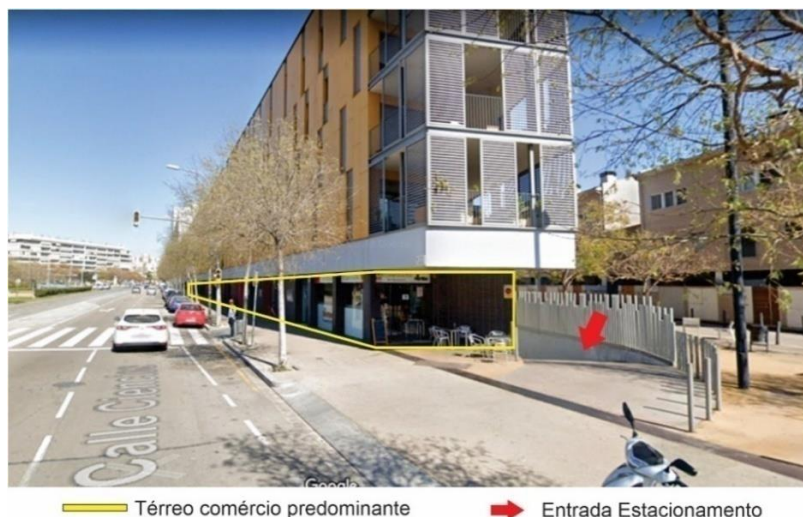
Figura 50 – Estacionamento – Conjunto Habitacional Feira Barcelona
