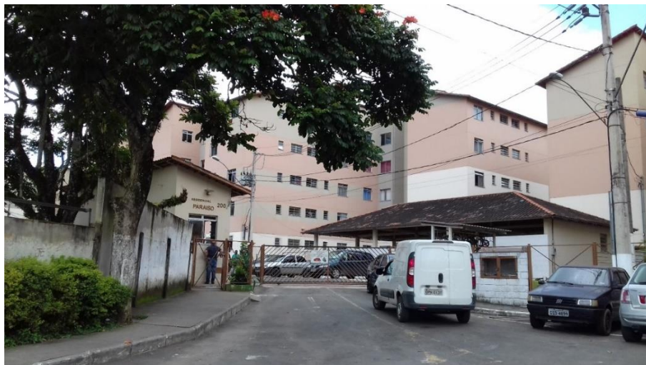
Figura 8 – Portaria (vista da rua) – Residencial Paraíso
