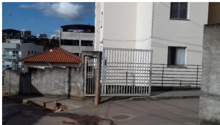
Figura 65 – Acesso Pedestres e Veículos do Residencial Vitória (vista da rua)
