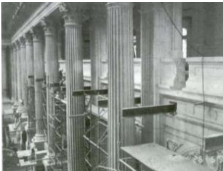
Figura 96: Vigas de aço em balanço Balcões Laterais – Sala São Paulo.
