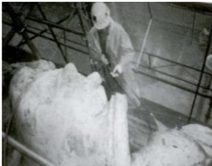
Figura 82: Aplicação do jato de água morna na Fachada Principal – Sala São Paulo.
