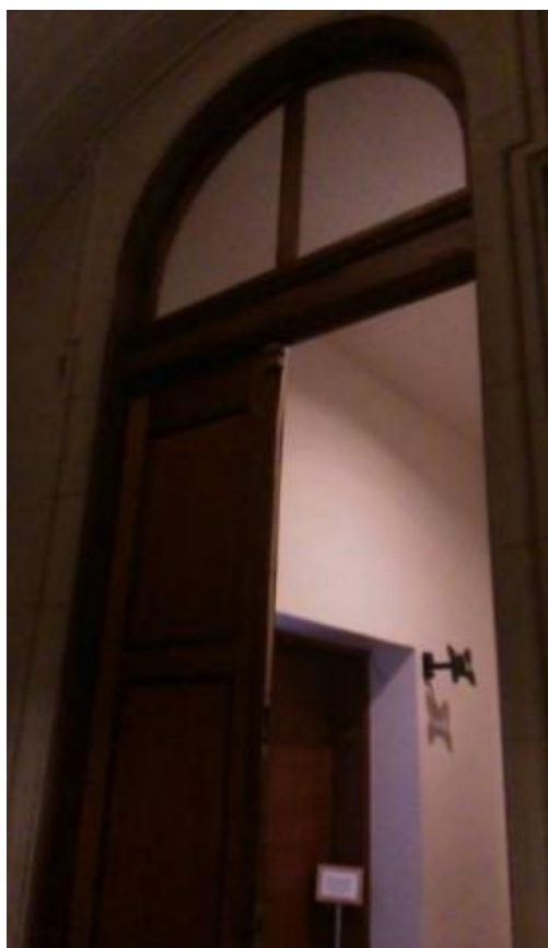
Figura 91: Restauro Caixilhos de Madeira – Sala São Paulo.
