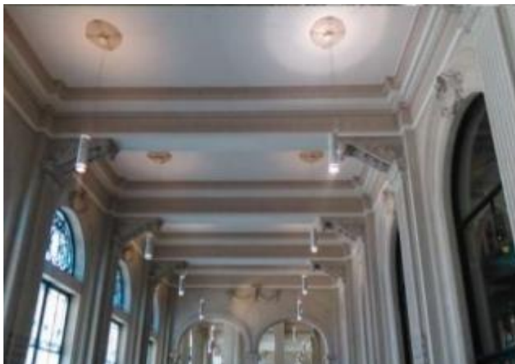
Figura 89: Restauro Paredes Internas – Sala São Paulo.
