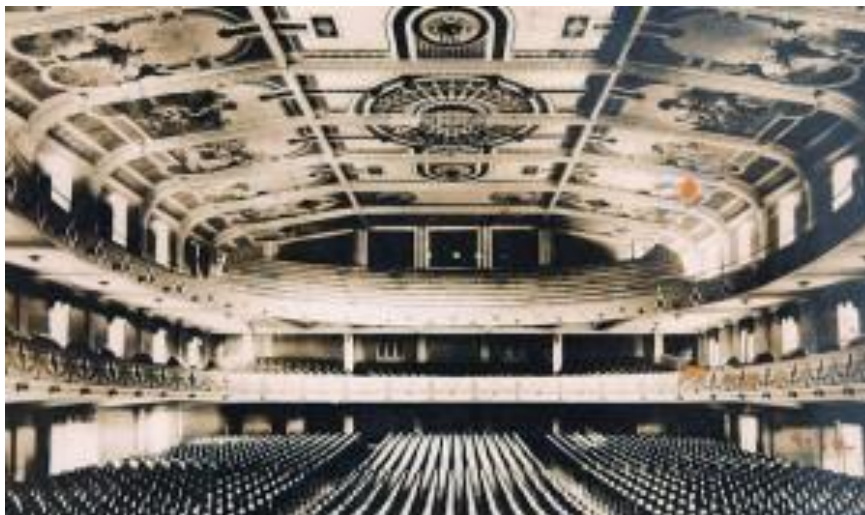
Figura 107: Vão sem pilastras sobre a platéia – Cine-Theatro Central.
