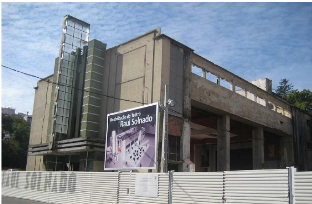
Figura 43: Vista do Cineteatro Capitólio – Início das obras em Abril de 2012.
