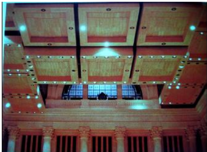
Figura 78: Forro Acústico – Sala São Paulo.
