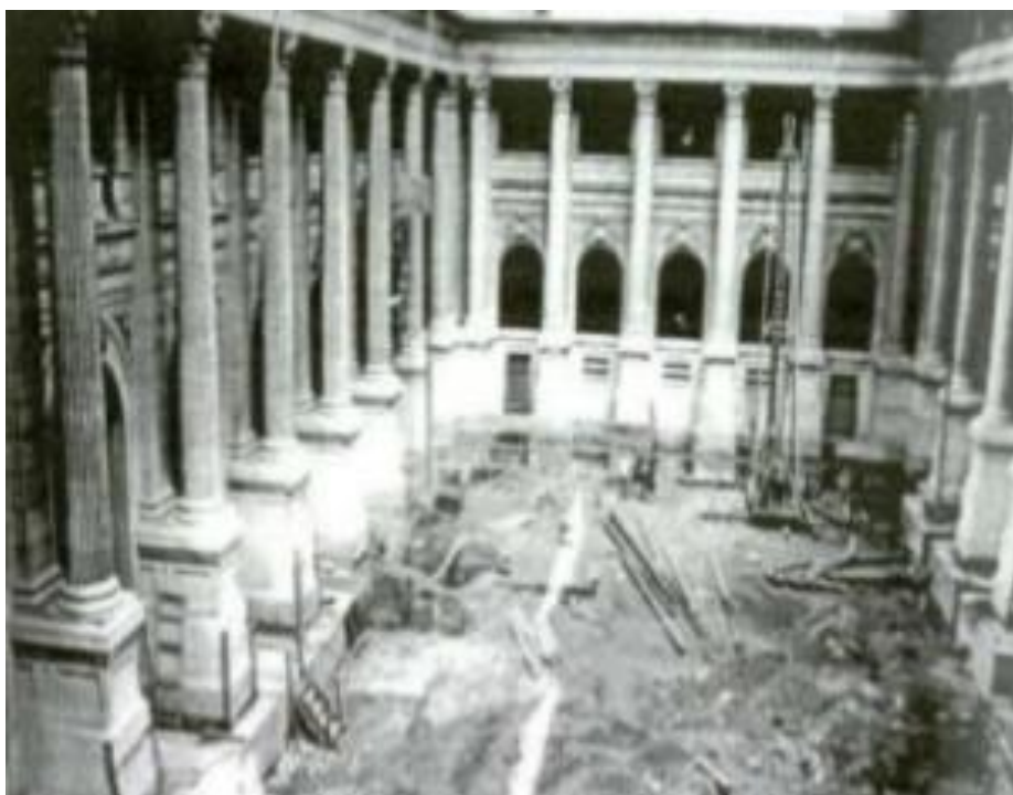
Figura 93: Novas Fundações – Sala São Paulo.
