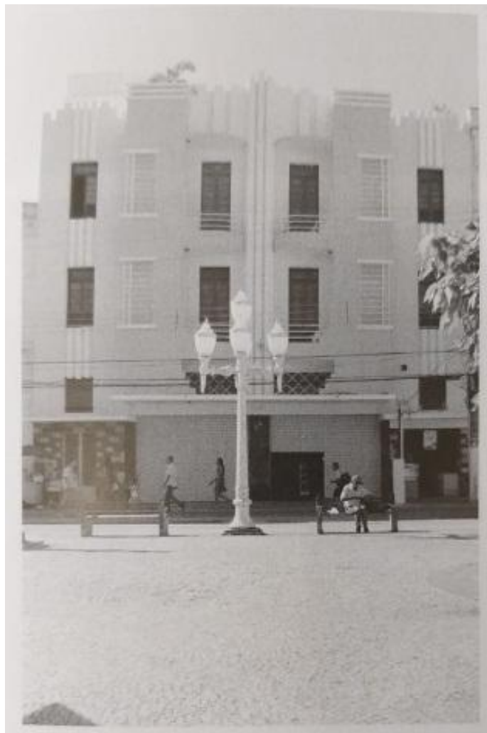
Figura 19: Fachada do prédio onde funcionou o Cine São Luiz – Dezembro de 2015.
