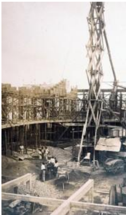
Figura 106: Demolição do Teatro Polytheama.
