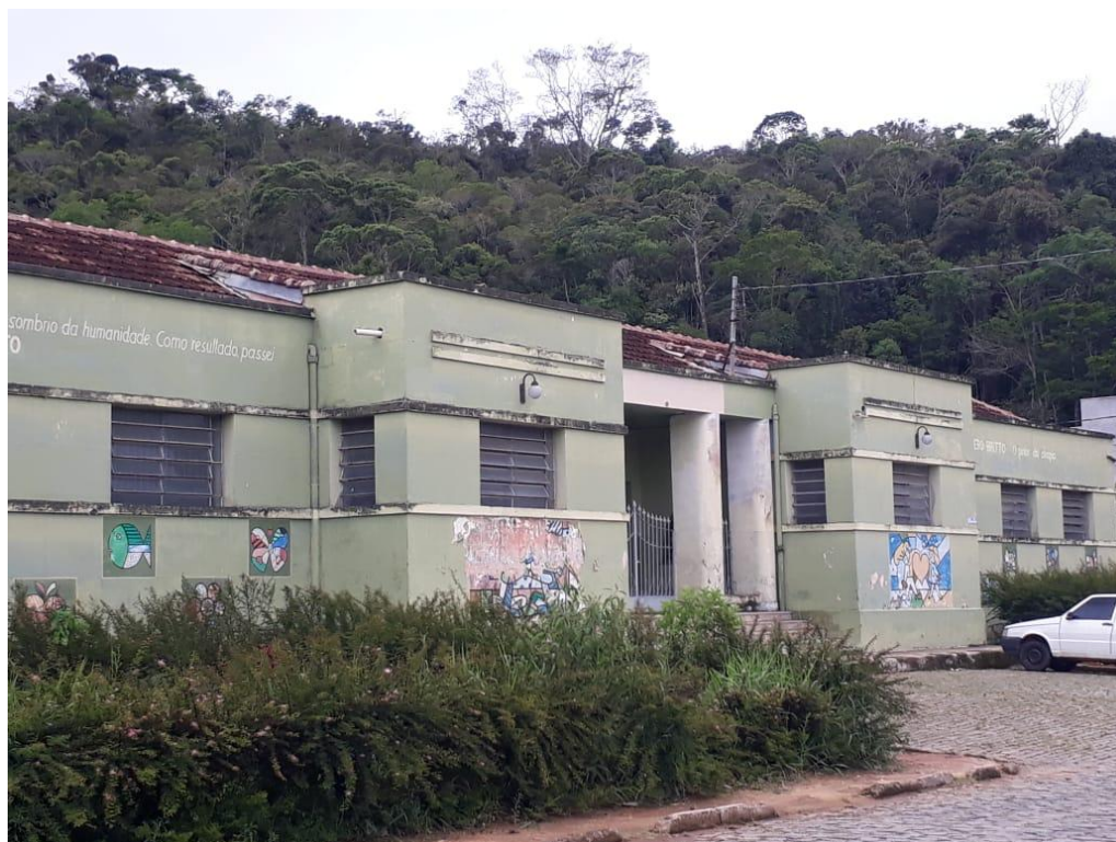
Figura 9: Antiga Escola Estadual, atualmente fechada – Bicas-MG.
