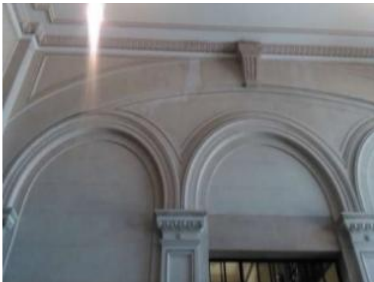
Figura 87: Restauro Elementos de Gesso – Sala São Paulo.
