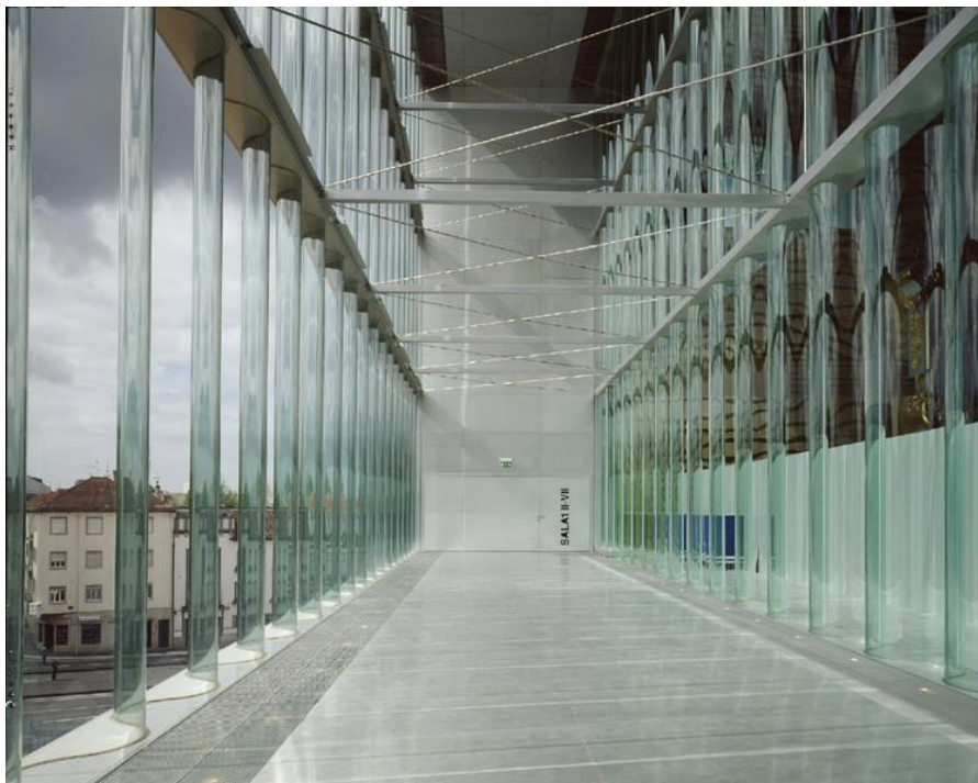
Figura 58: Cortinas de Vidro nas extremidades do Auditório – Casa da Música.
