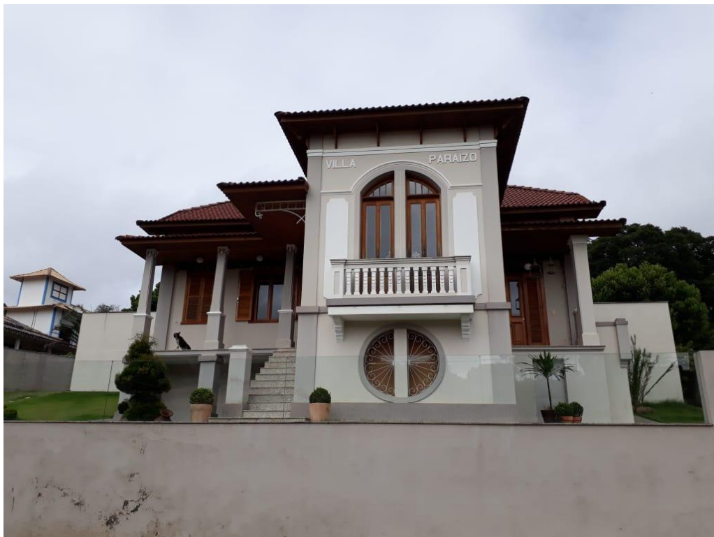
Figura 15: Vila Paraizo (recentemente reformada) – Bicas-MG.
