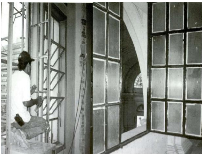
Figura 90: Restauro Caixilhos Metálicos – Sala São Paulo.
