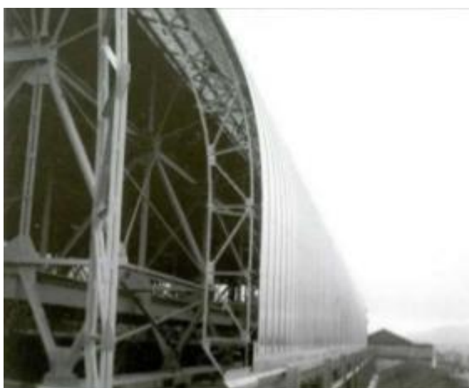
Figura 99: Nova Cobertura – Sala São Paulo.
