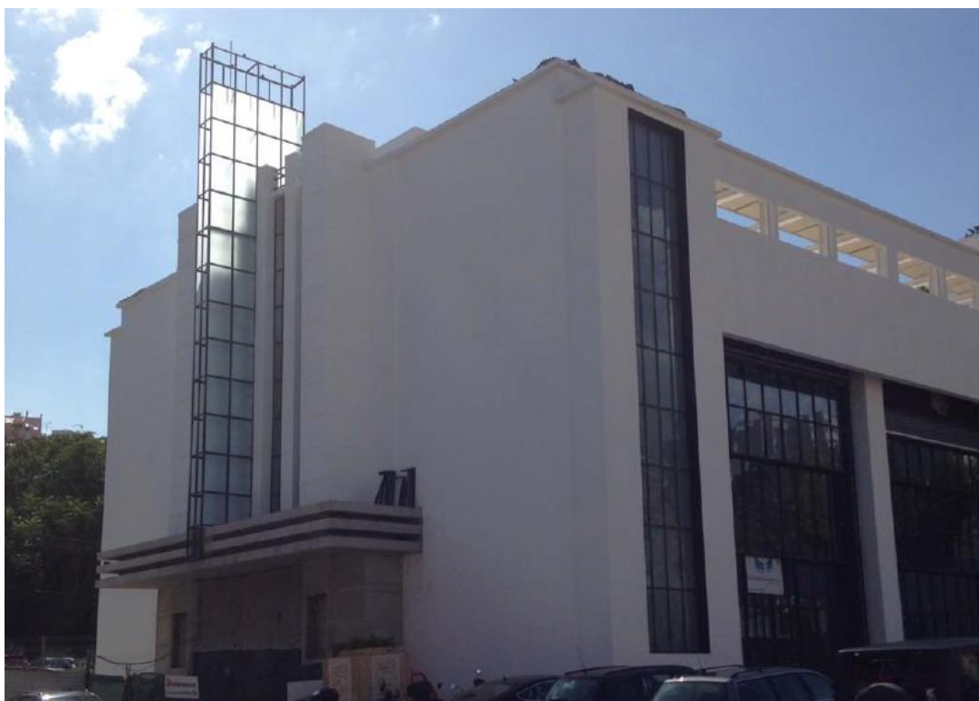
Figura 44: Vista do Cineteatro Capitólio – Fase de acabamento em Dezembro de 2014.
