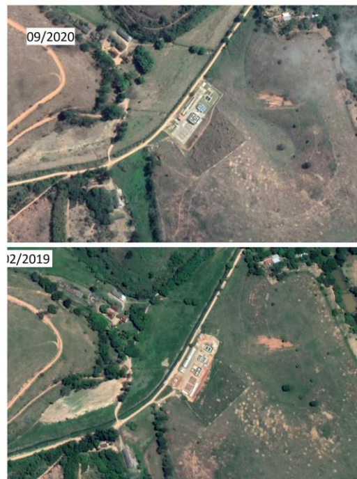
Figura 6 – Área da ETE em fevereiro de 2019 e setembro de 2020
