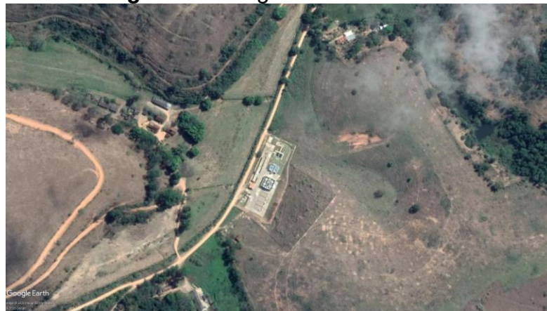
Figura 3 – Imagem aérea da ETE.
