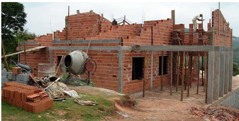
Figura 3 - Alvenaria em bloco cerâmico
