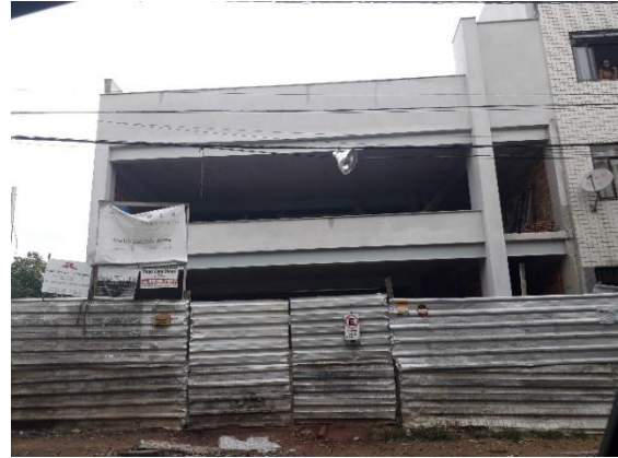
Figura 22- Obra 6 Conforme para Barreiras
