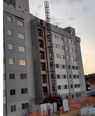
Figura 9- Obra 14 Conforme para Fechamento no Transporte de carga vertical
