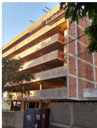
Figura 10- Obra 13 Conforme para Proteção periférica da edificação
