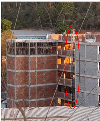
Figura 19- Obra 13 Conforme para Remoção de entulhos Fonte: Autor(es), 2020
