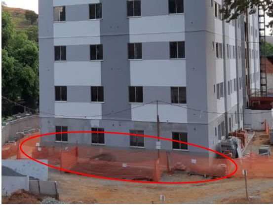
Figura 15- Obra 14 Conforme para Sinalização
