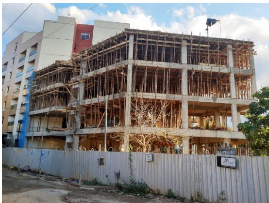
Figura 23- Obra 12 Conforme para Altura Mínima
