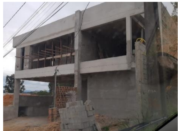
Figura 18- Obra 20 Conforme para Organização e limpeza
