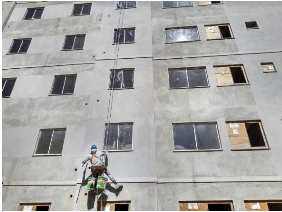
Figura 13- Obra 14 Conforme para EPI Fonte: Autor(es), 2020
