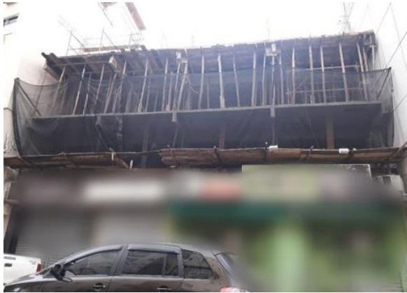
Figura 5- Obra 7 Conforme para Proteção Coletiva
