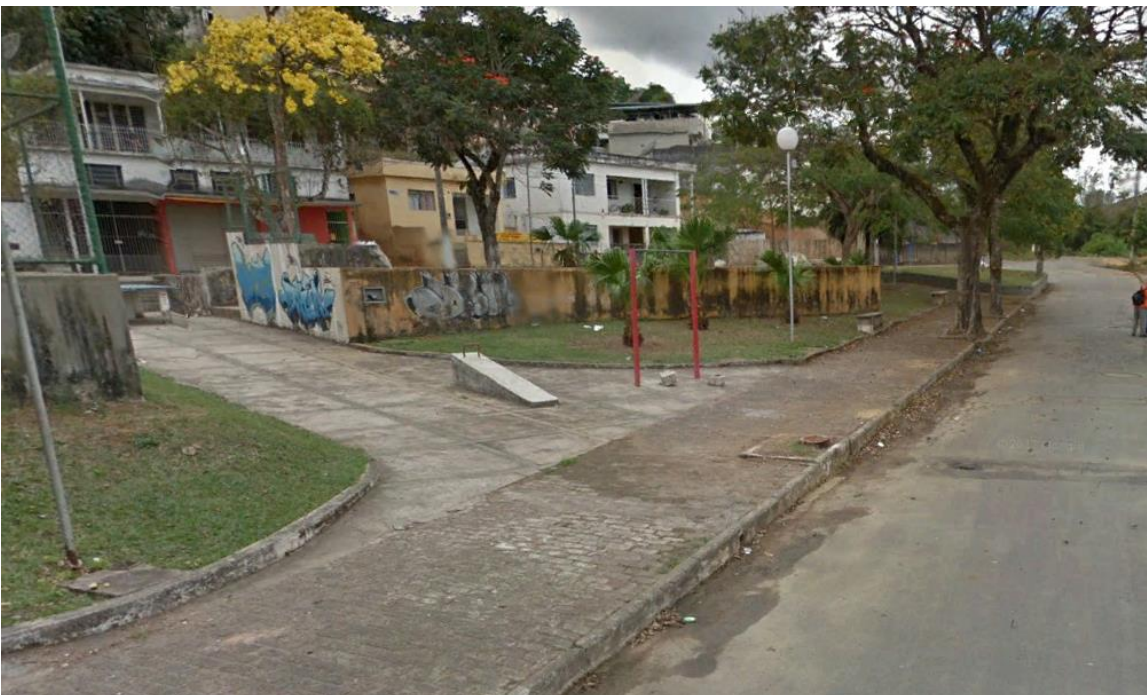
Figura 29: Mobiliário urbano da Praça Ana Esméria em estado de degradação e incorreto.
