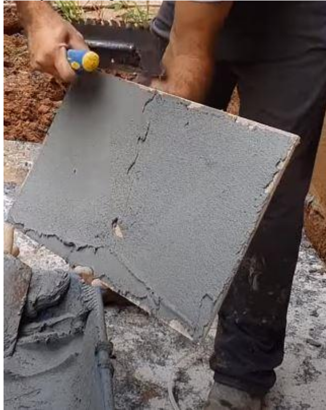
FIGURA 10 - Aplicação da Argamassa Colante na Placa Cerâmica - Centro
