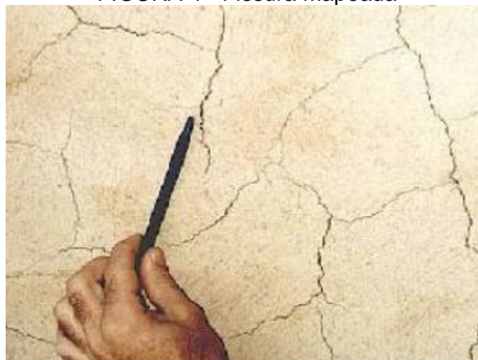
FIGURA 4 - Fissura Mapeada
