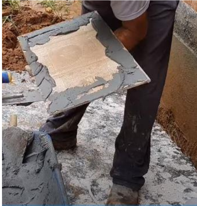
FIGURA 9 – Aplicação da Argamassa Colante na Placa Cerâmica - Bordos
