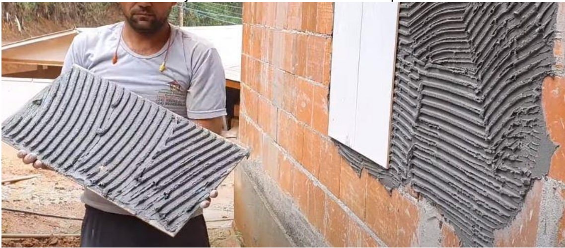
FIGURA 11 - Formação dos Cordões com Desempenadeira Dentada
