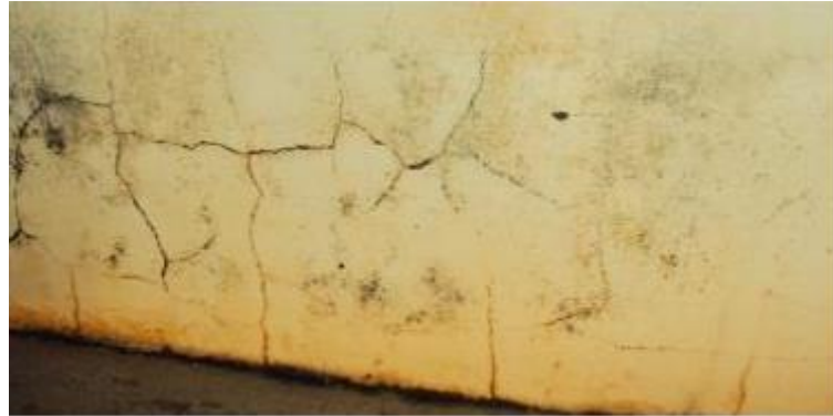
FIGURA 5 - Fissuras Geométricas
