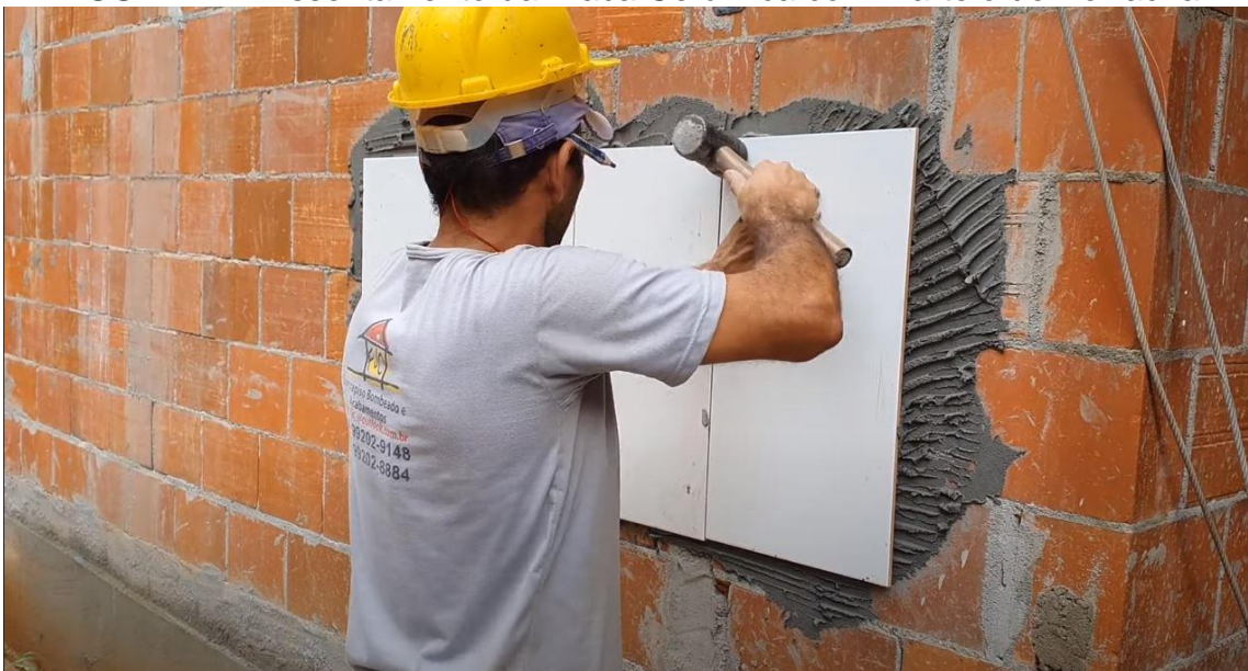
FIGURA 12 - Assentamento da Placa Cerâmica com Martelo de Borracha
