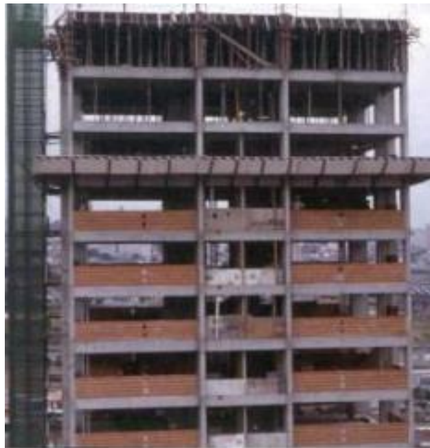
FIGURA 9 - Estrutura de laje cogumelo.
