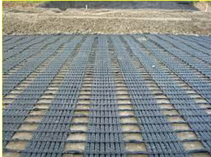
Figura 13 - Adoção de geogrelhas em área de Aterro com solo mole.
