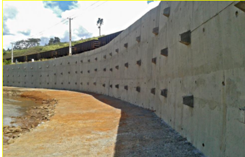
Figura 11 - Estrutura de contenção: cortinas atirantadas.
