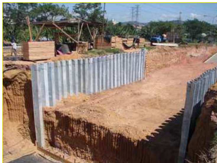
Figura 12 - Cortina de contenção: estacas-prancha.
