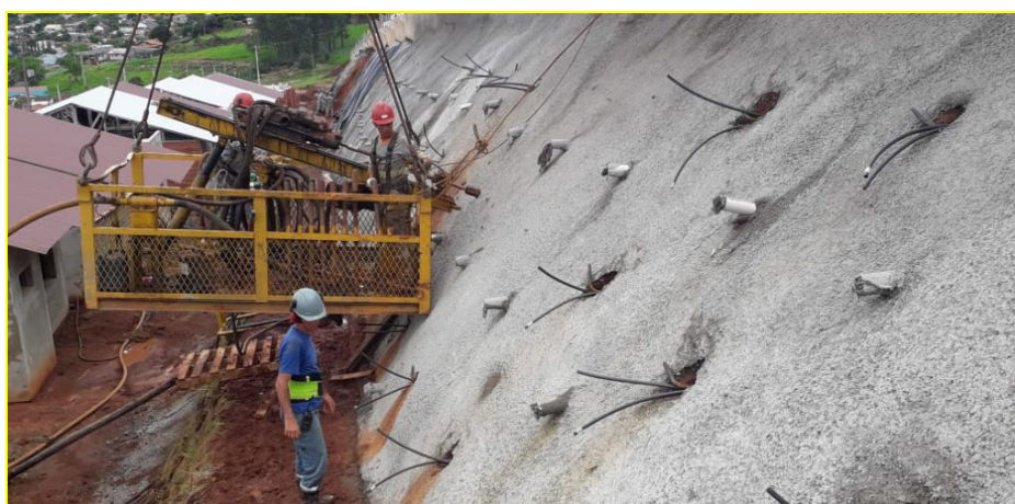
Figura 10 - Execução de obra de contenção com solo grampeado.
