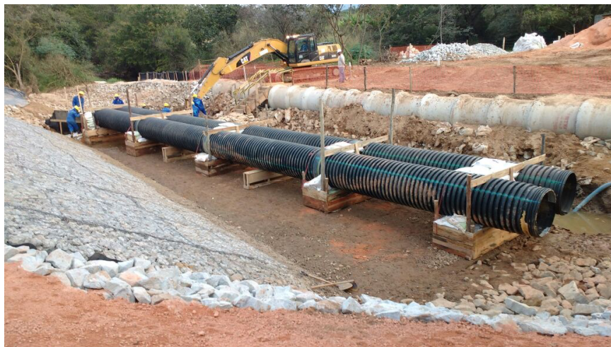
Figura 21 - Ensecadeira com tubos de PEAD do km356+600.
