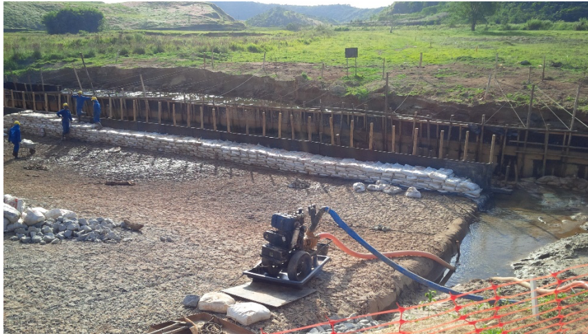
Figura 16 - Ensecadeira construída para obra do km150+000.
