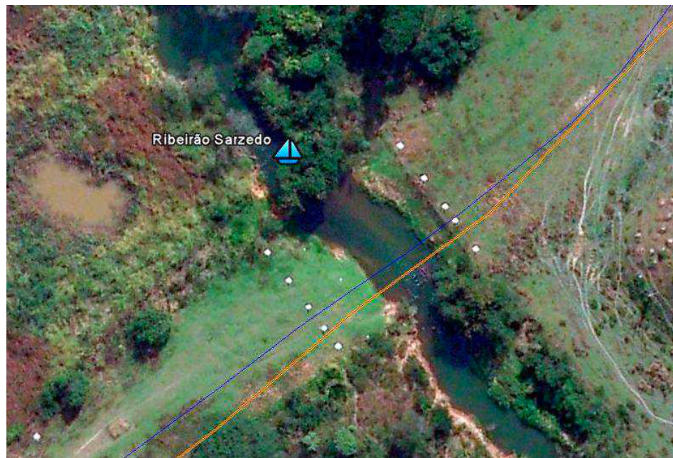
Figura 17 - Vista aérea da travessia de dutos no Ribeirão Sarzedo.
