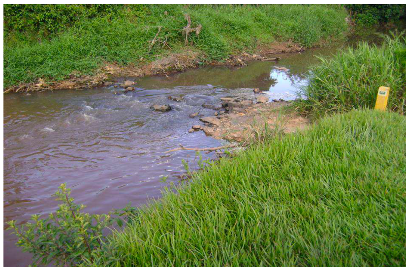
Figura 18 - Enrocamento de pedras a montante da travessia.
