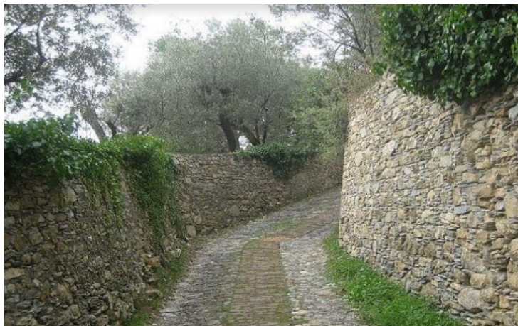
Figura 6 - Muro de pedras.
