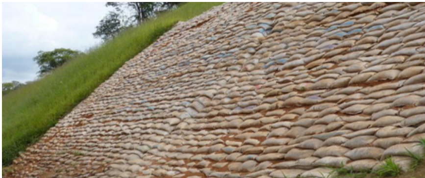
Figura 7 - Exemplo de muro de solo-cimento ensacado.
