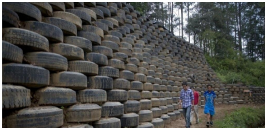
Figura 8 - Muro solo-pneu.
