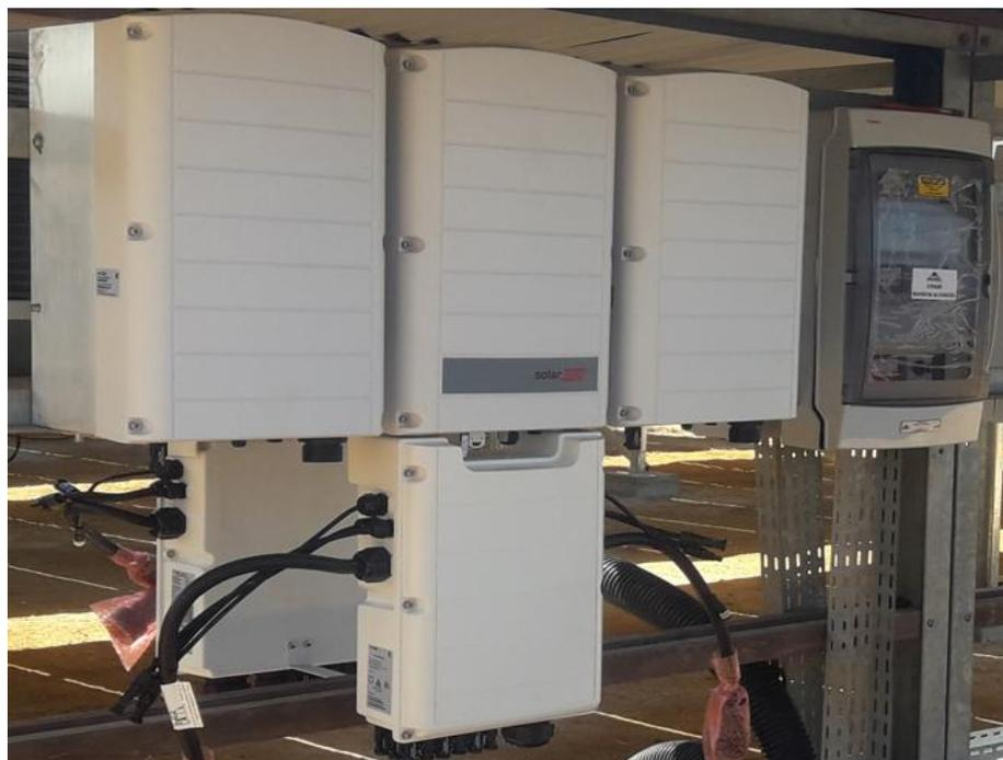
**Imagem 10** – Inversor SolarEdge 75KW
