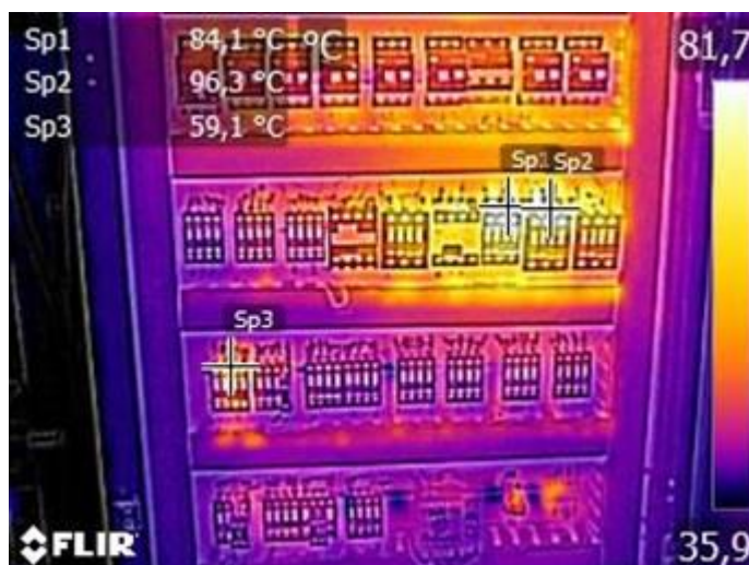
Figura 1: Aplicação da termografia na inspeção elétrica.
