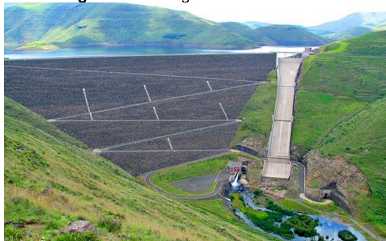
Figura 3 – Barragem de enrocamento
