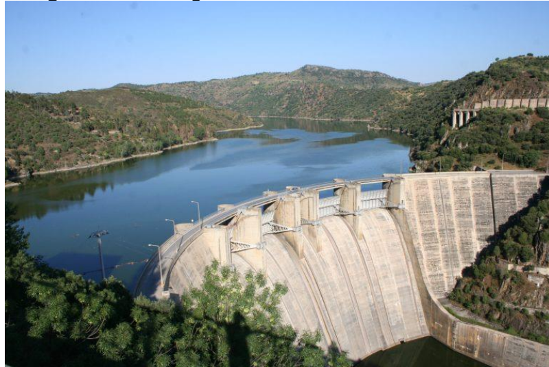
Figura 4 – Barragem de concreto em forma de arco
