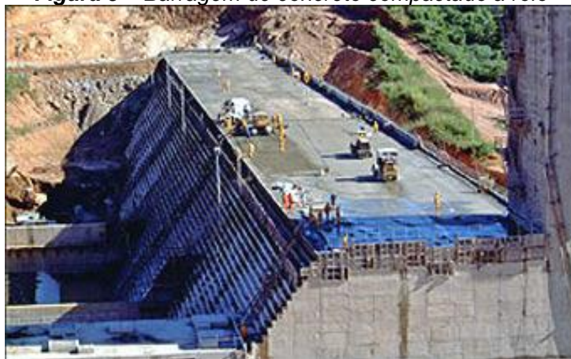
Figura 5 – Barragem de concreto compactado a rolo
