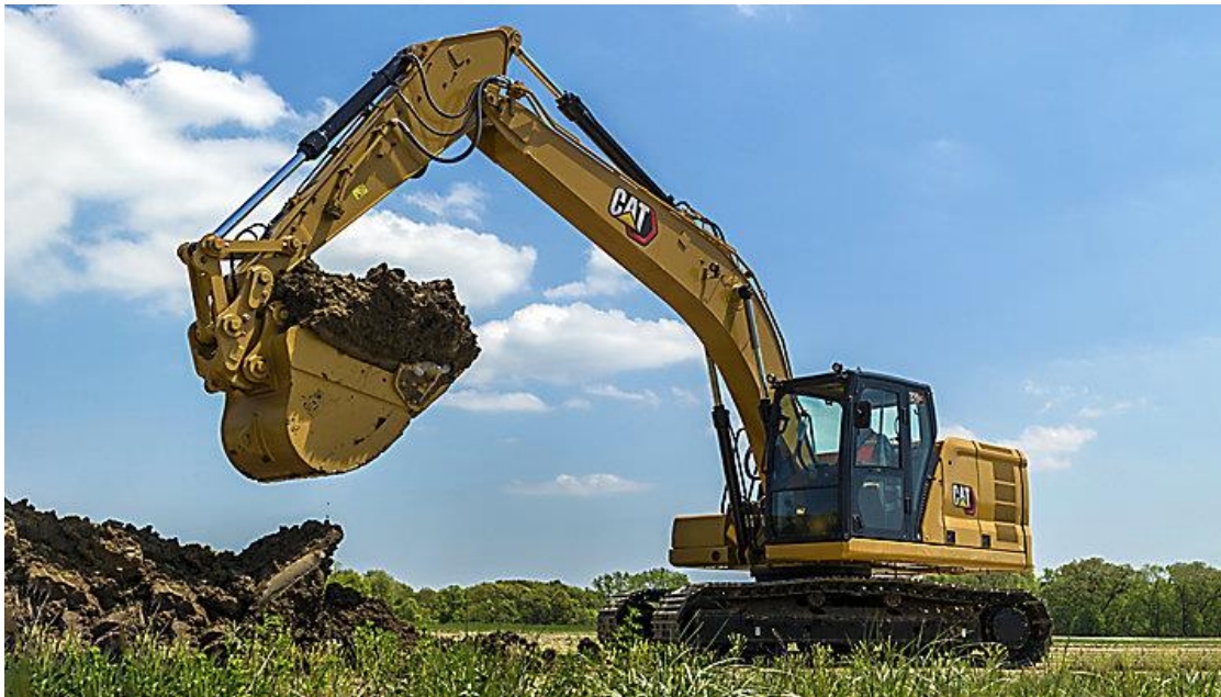
FIGURA 1 – ESCAVADEIRA HIDRÁULICA RETIRANDO MATERIAL
