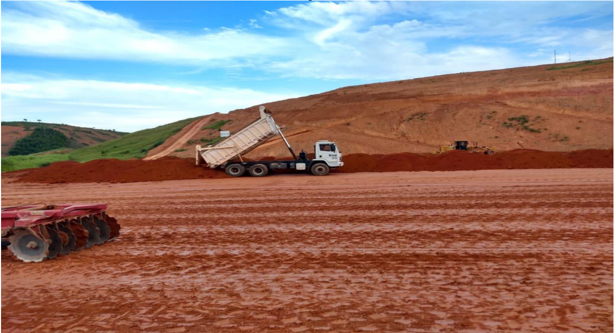
FIGURA 13 – LANÇAMENTO DO MATERIAL
