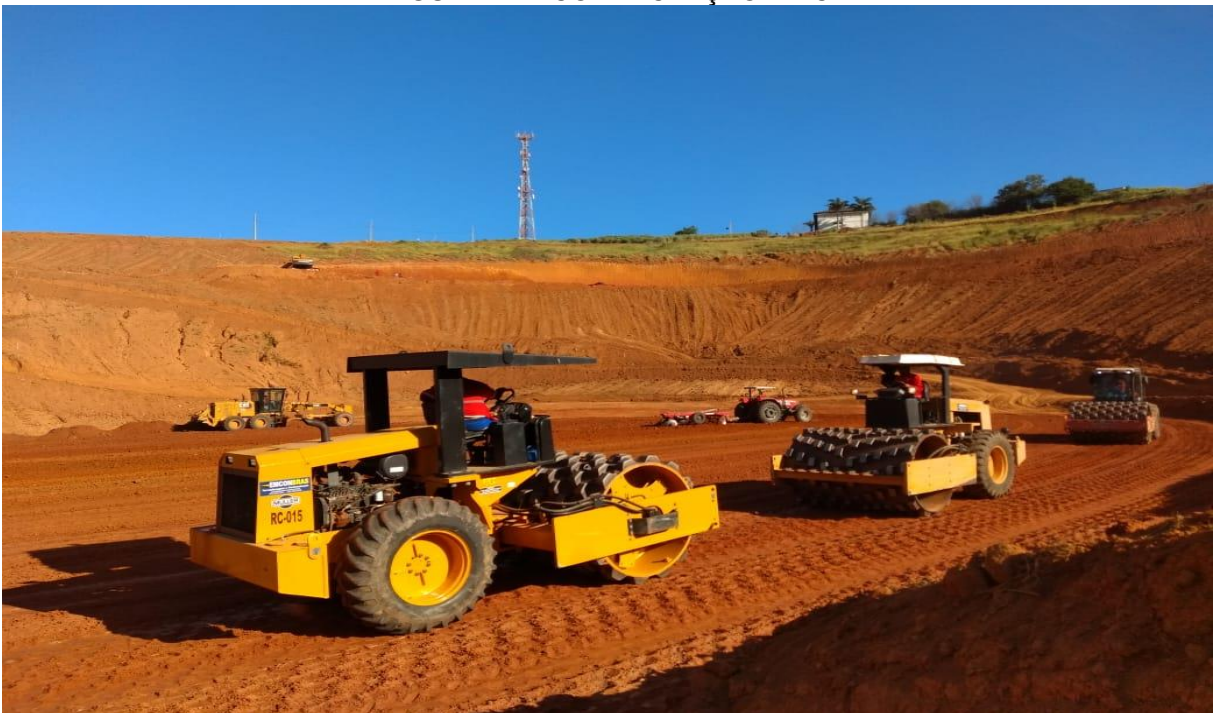
FIGURA 14 – COMPACTAÇÃO DA CAMADA
