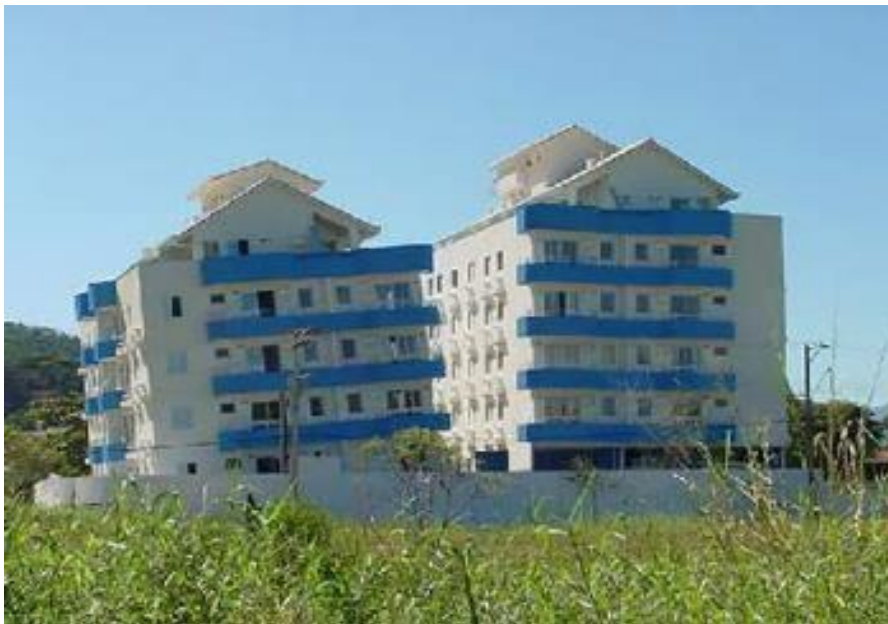
FIGURA 5 – PRÉDIO TOMBADO POR RECALQUE
