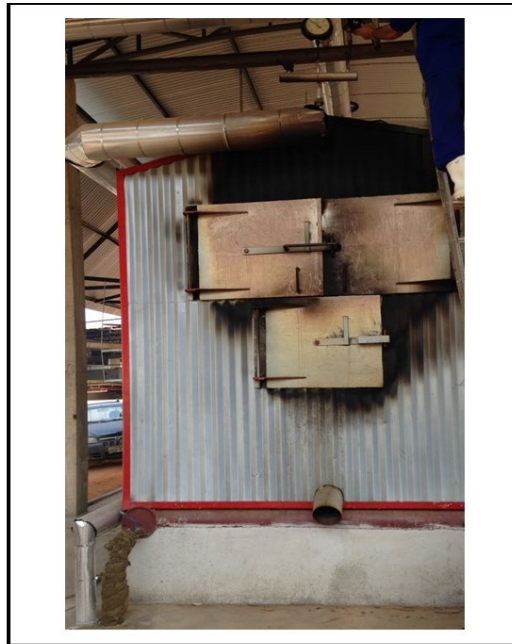
Figura 15: Retrocesso de gases pela porta da fornalha
