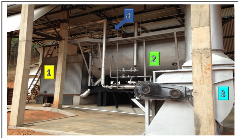
Figura 8: Divisão das principais partes da caldeira
