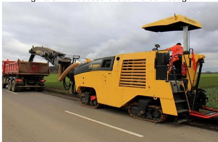
Figura 8 – Processo executivo de fresagem
